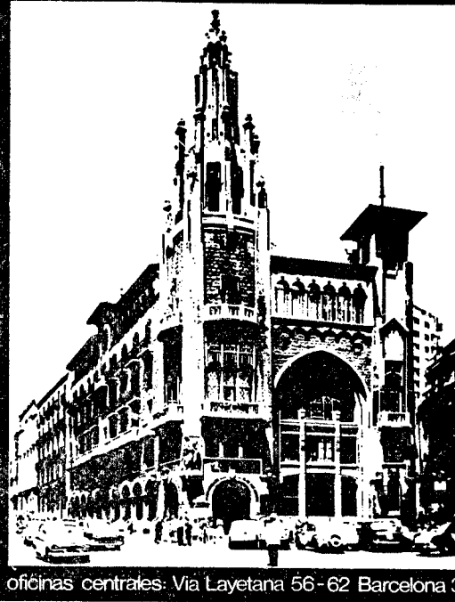
oficinas centrales: Via Layetana 56-62 Barcelona 3
