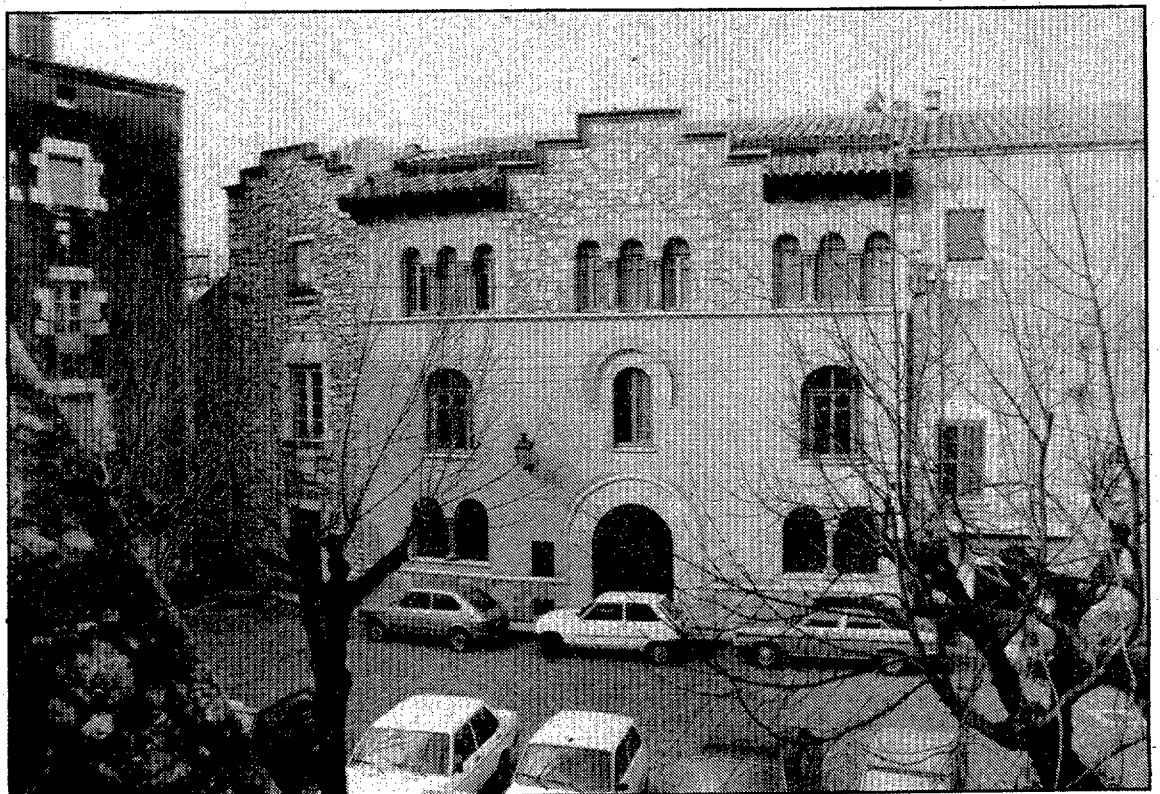
Un aspecte de la plaça dels Lledoners, amb la Casa de la Caritat al fons, que presenta la façana restaurada.
