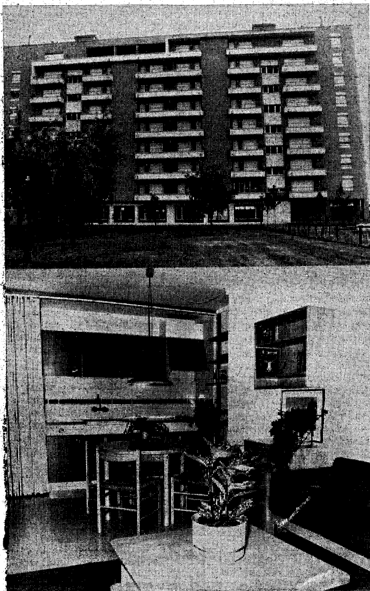
Un aspecto del edificio «Migjorn», situado en la zona del Mediodía de nuestra ciudad. La foto inferior recoge un aspecto del interior de uno de los apartamentos.
