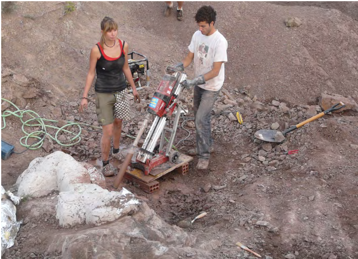
Figura 4. Per tal d'utilitzar el sistema del ciment expansiu en l'extracció de l'esquelet del mirador es van fer un conjunt de forats al voltant del perímetre del fòssil amb un trepant amb una broca de corona de diamant
