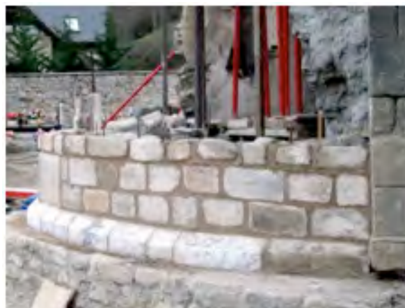
Figura 17. Es materiaus emplegadi an estat eth mortèr de caudia entàs juntes e plaçament des pèires nòbles e mortèr d'ormigon entath farciment interior. Inici dera collocacion des pèires originaus recuperades der esbaus des estructures de 1780
