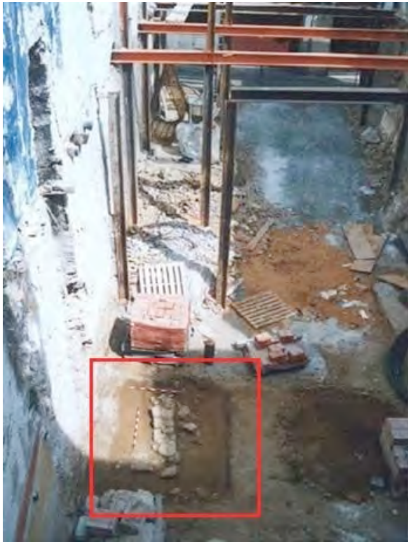
Figura 8. Vista general de les excavacions al carrer Nou, núm 16
