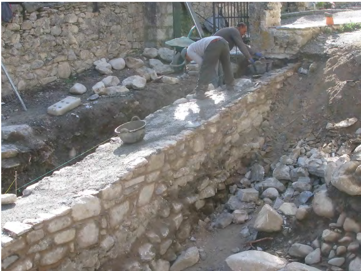
Figura 30. Es prumèri trabalhs de consolidacion s'inicièren pera muralha que barraue per èst era fortificacion. Aguesta s'a repujat ath torn de 50 cm., encara qu'era sua còta definitiva vierà mercada pes nivèus finaus deth paviment de labades que se plaçarà ena plaça.
