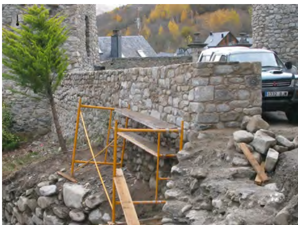
Figura 32. Dempús de consolidar era tor s'inicien es trabalhs ena muralha nòrd. Aguesta recupèrè ath torn de 50 cm. de mejana ena sua nautada, excèpte en sòn extrem oèst, a on puge 95 cm.
