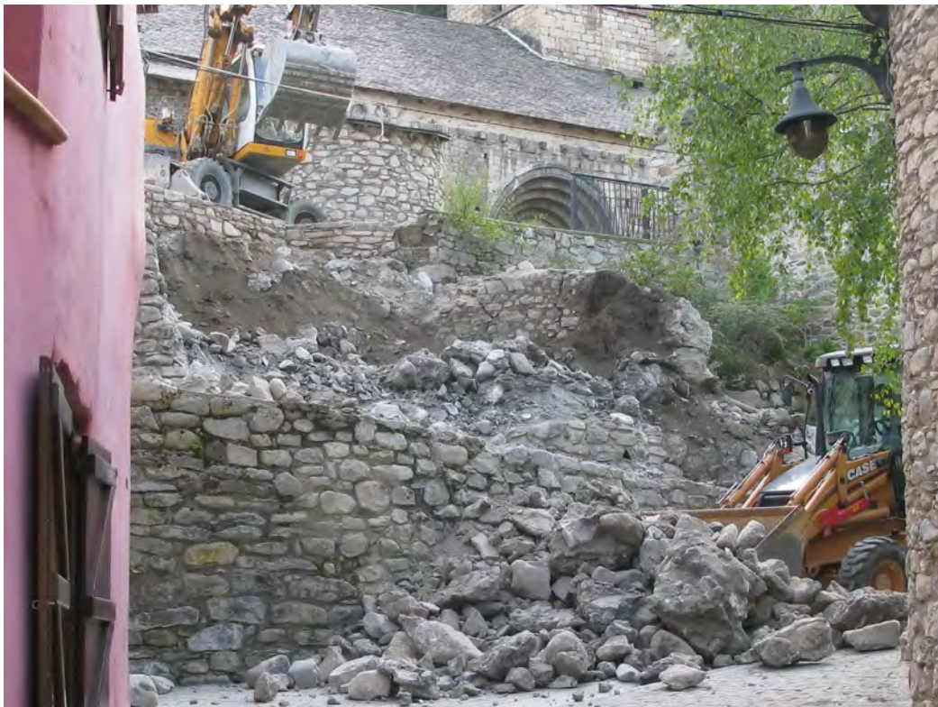
Figura 28. Procès d'esbaus deth tram èst dera grada.
