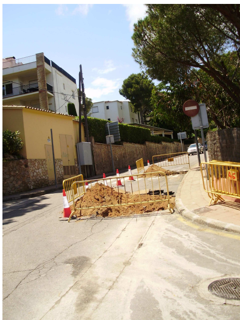
Cales practicades al sector oest. Al detall una caixa de cables moderns i s'aprecia la gresa natural.
