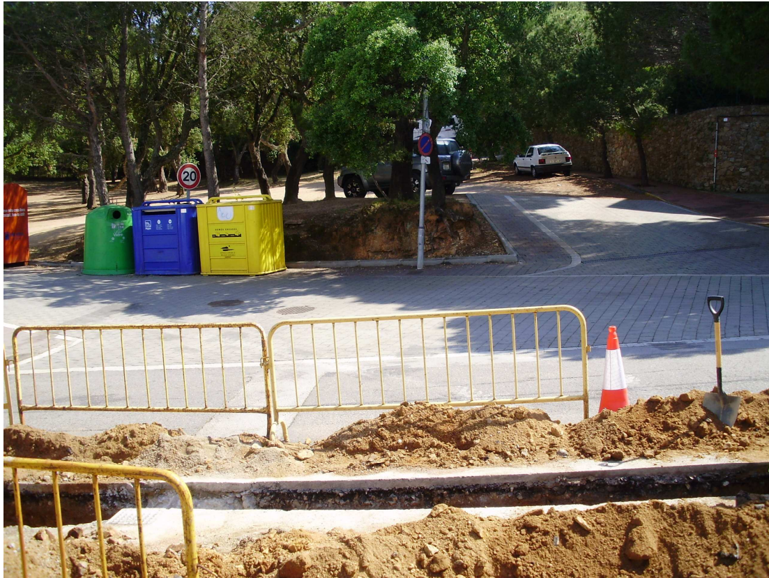
Sector xamfrà c/ Sirena. Al fons s'aprecia com es va retallar el terreny natural per obrir el carrer actual.
