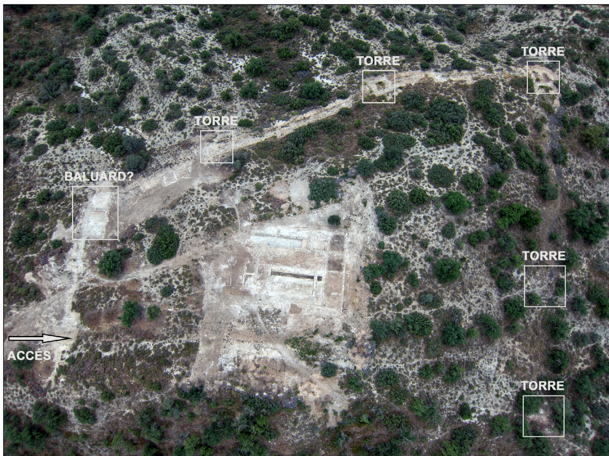
Figura 16. Vista aèria del recinte emmurallat, amb les cinc torres fins al moment identificades
