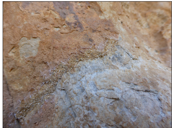
Figura 36. Entonat posterior del morter.
