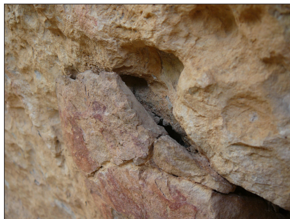
Figura 18. Fractures prèvies a la caiguda de fragments.
