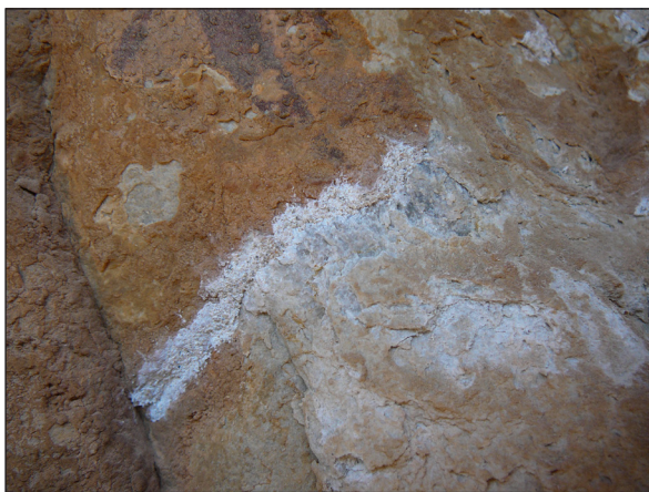
Figura 35. Aplicació de morter de calç a la zona amb descamacions i despreniments.
