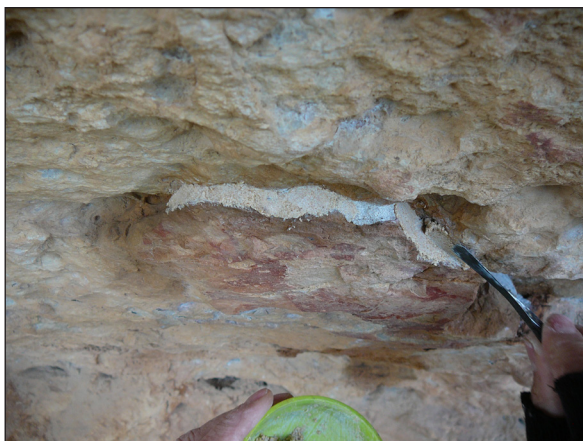
Figura 23 i 24. Rebliment i fixació de desplaçaments amb morter de calç i una segona capa de morter acolorit.
