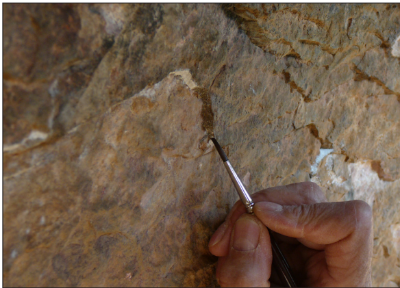
Figura 27 i 28. Fixació de fissures i desplaçaments amb morter de calç i posterior entonat.
