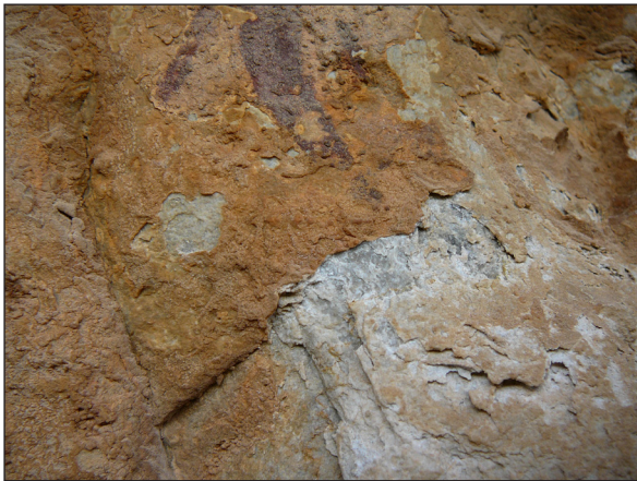
Figura 8. Cristal·lització de sals i despreniments.
