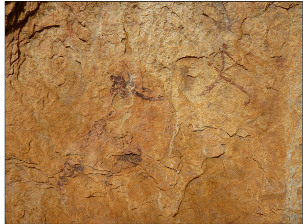
Figura 39. Vista general de les fissures fixades amb morter de calç.
