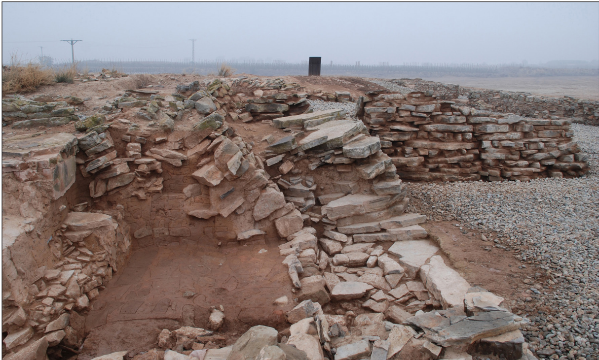
Figura 6. Vista en secció dels paraments de la muralla MUR-1. S'aprecia l'evolució constructiva i el grau elevat de desplom especialment dels paraments interiors
