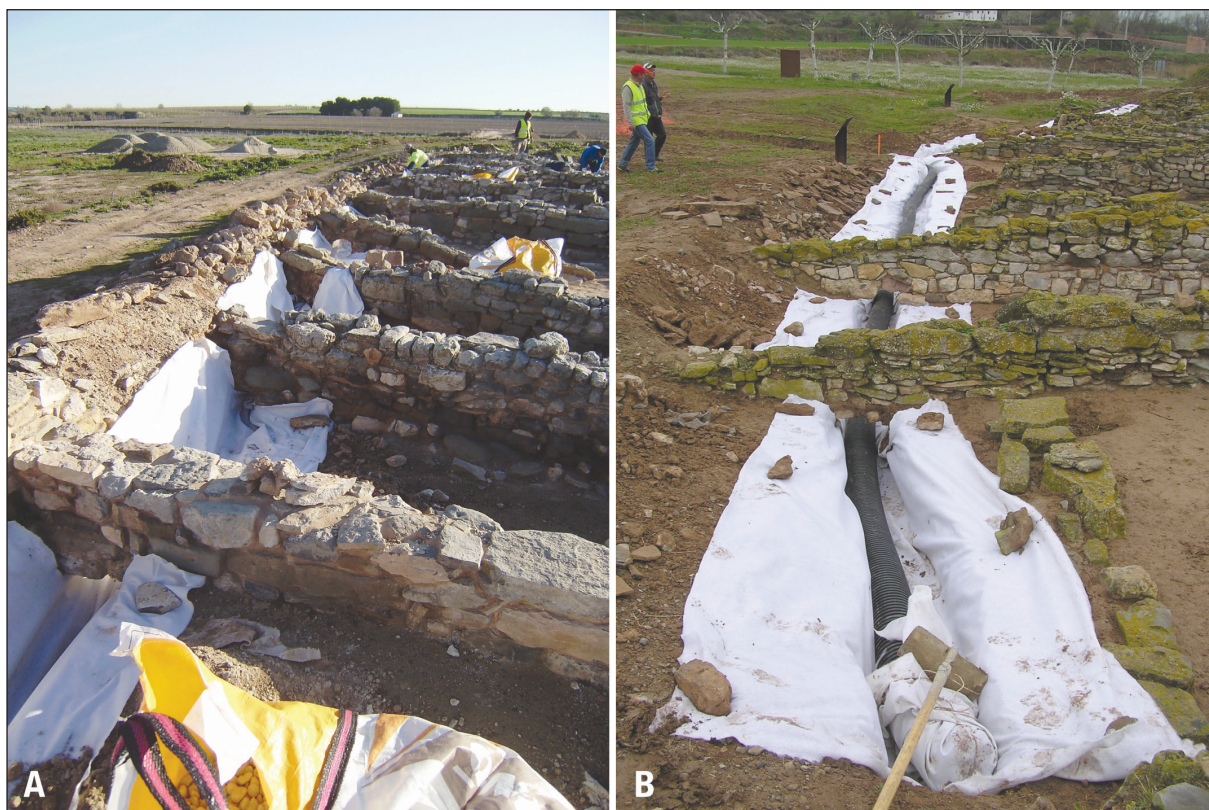
Figura 22. Vistes de la instal·lació dels drenatges als habitatges adossats a la muralla de l'ibèric antic (MUR-2) (A) i a la muralla de l'ibèric ple (MUR-3) (B)
