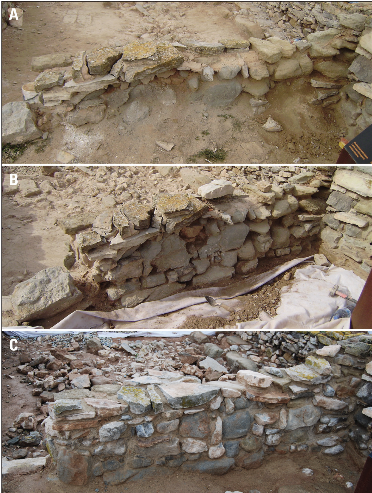
Figura 23. Procés de consolidació d'un dels murs del jaciment (MR-40): vista de l'estat de l'estructura abans de la intervenció (A), vista de l'estructura després de la neteja (B) i vista de l'estructura un cop consolidada (C)
