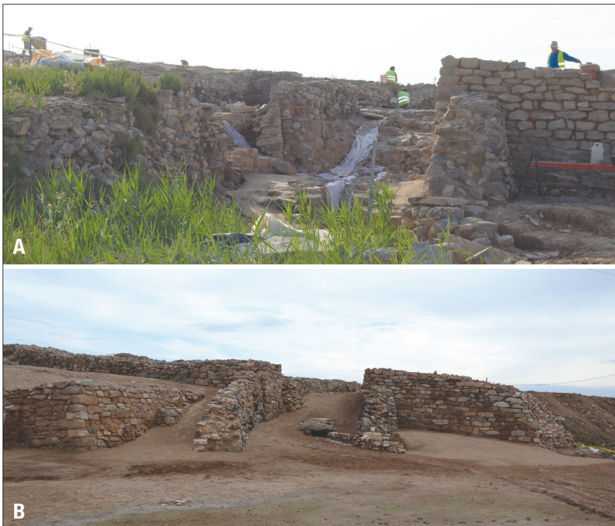
Figura 24. Procés de restauració de la porta d'Ilerda: vista dels treballs en curs (A) i vista un cop consolidada i restaurada
