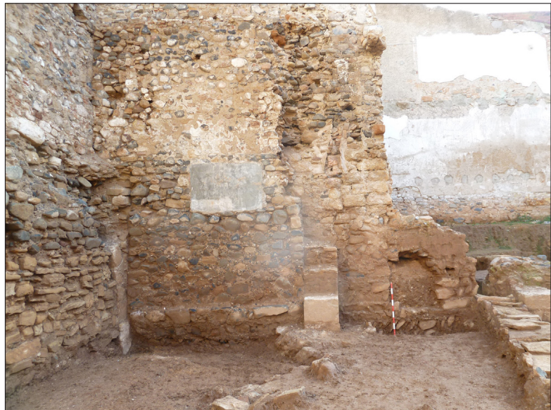
Vista dels arrencaments dels arcs de diafragma de l'antiga casa de Poblet, en part modificats amb la construcció de la muralla al segle XIV
