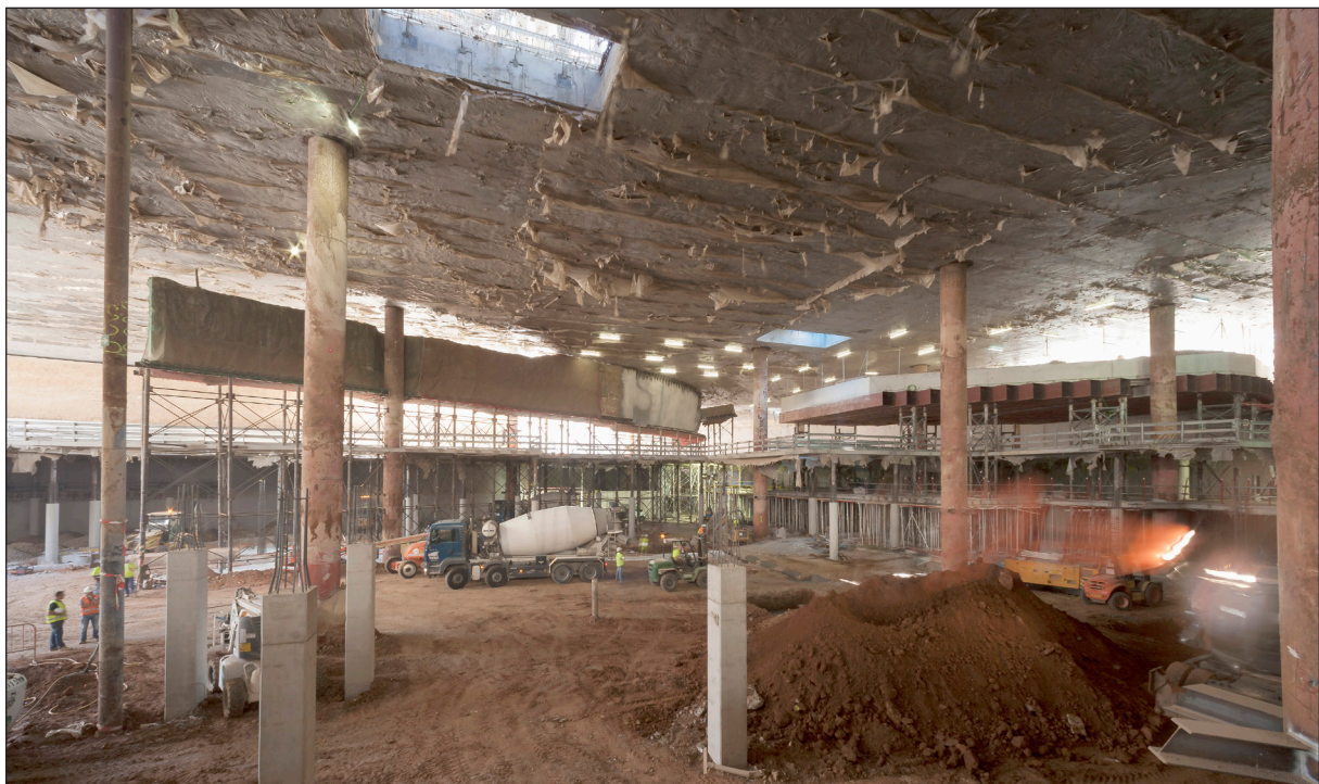
Figura 11. Contraescarpa i restes romanes estintolades durant el procés constructiu
