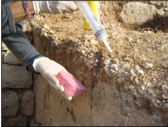
Fig. 13. Aplicació d'emulsió acrílica per injecció amb la finalitat de cohesionar el mur de tàpia
