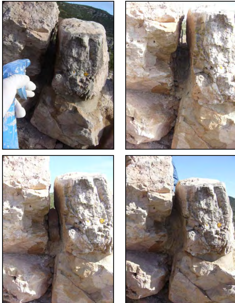
Fig.12. Procés d'aplicació del morter
