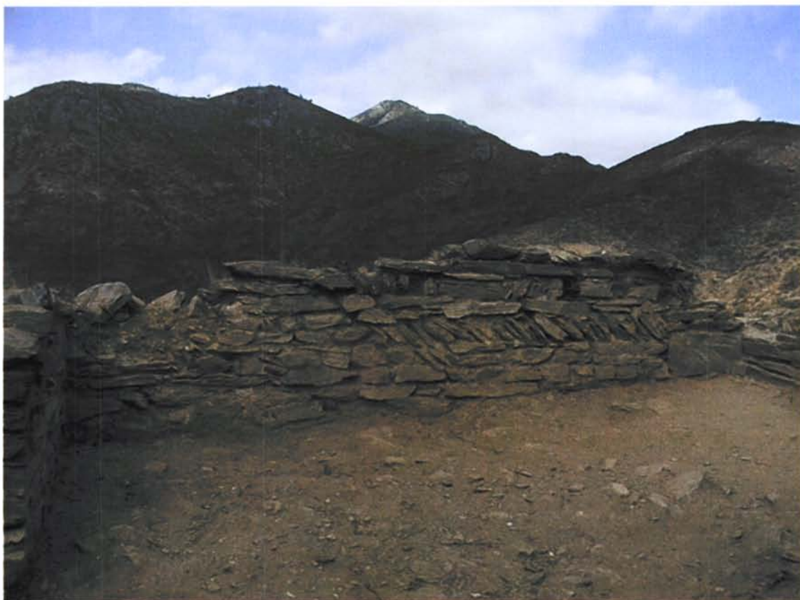
Vista de la cara interna del mur 13 un cop completada l'excavació del sector 3.
