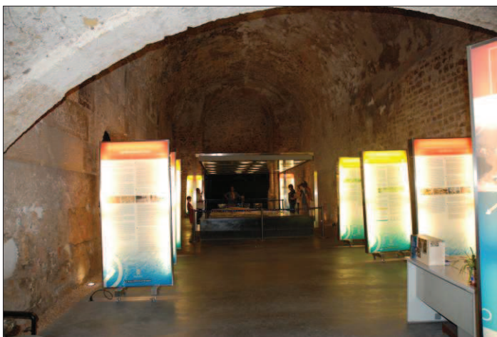
Figura 3. Estat interior de la volta del Pallol.
