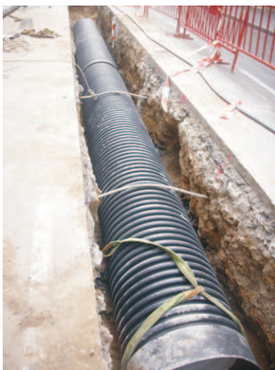
Foto 11. Tram de rasa davant dels núms. 11 i 13 del carrer de Maria Cristina, un cop s'havia col·locat el nou col·lector.
