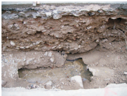
Foto 21. Imatge de la rasa del col·lector davant del solar núm. 27 del carrer de Maria Cristina.
