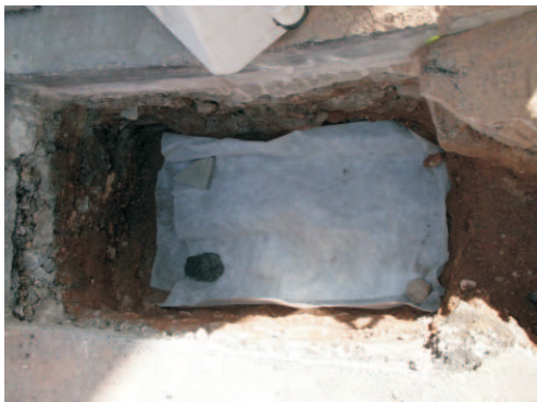
Foto 41. Imatge de la nova escomesa procedent del solar núm. 49 del carrer de Maria Cristina, un cop es va cobrir l'estructura localitzada (268).
