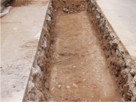
Foto 25. Paviment 226 davant del solar núm. 36 del carrer de Maria Cristina (en un costat i en un altre de la rasa del nou col·lector). En el centre: estrat que cobria la conducció que s'ha substituït (105).
