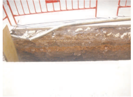
Foto 2. Imatge del perfil oest de la rasa del nou col·lector, en l'extrem sud (davant dels nùms. 7 i 12 del carrer de Maria Cristina).
