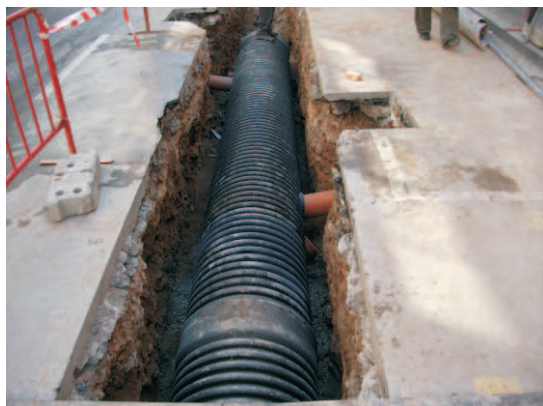
Foto 15. Tram de rasa davant del núm. 17 del carrer de Maria Cristina, un cop s'havia col·locat el nou col·lector.
