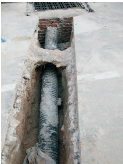
Foto 13. Rasa, des de l'est, on s'ha encabit la nova escomesa procedent del núm. 14 del carrer de Maria Cristina.
