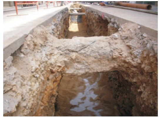
Foto 8. Imatge de la rasa del nou col·lector tot just al nord del caixer on se situa la conducció de gas 118/119.
