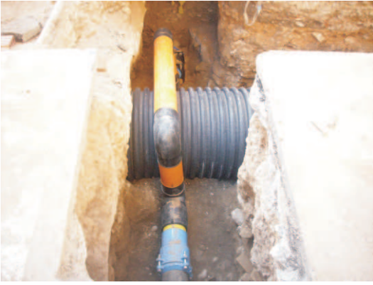
Foto 7. Noves conduccions de la part sud de la rasa: gas que substitueix a l'antiga (118, en un nivell superior) i col·lector hídric (sota).
