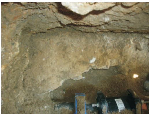
Foto 5. Sector nord del paviment 124. Sota, hi ha part de la nova conducció de gas que ha substituït a l'antiga (118)
