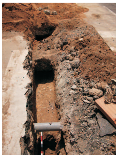
Foto 17. Paviment 144=145, localitzat al costat del solar núm. 17 del carrer de Maria Cristina, en una de les escomeses realitzades.
