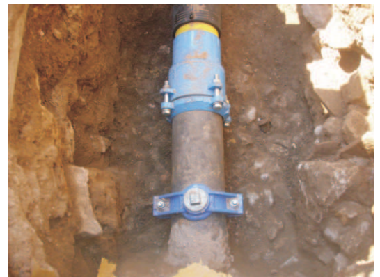
Foto 6. Fonaments 121 (a l'esquerra) i 122 (a la dreta), tallats per la rasa 119, on es va situar la conducció de gas 118 (en el centre).
