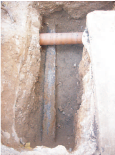
Foto 3. Imatge, des de l'est, de la conducció de gas 118, situada dins la rasa 119.
