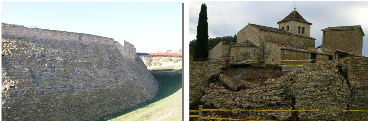
Fig. 2. Esquerra: tram de muralla restaurat i dreta tram ensorrat després del temporal de pluges del mes de novembre de 2013.
