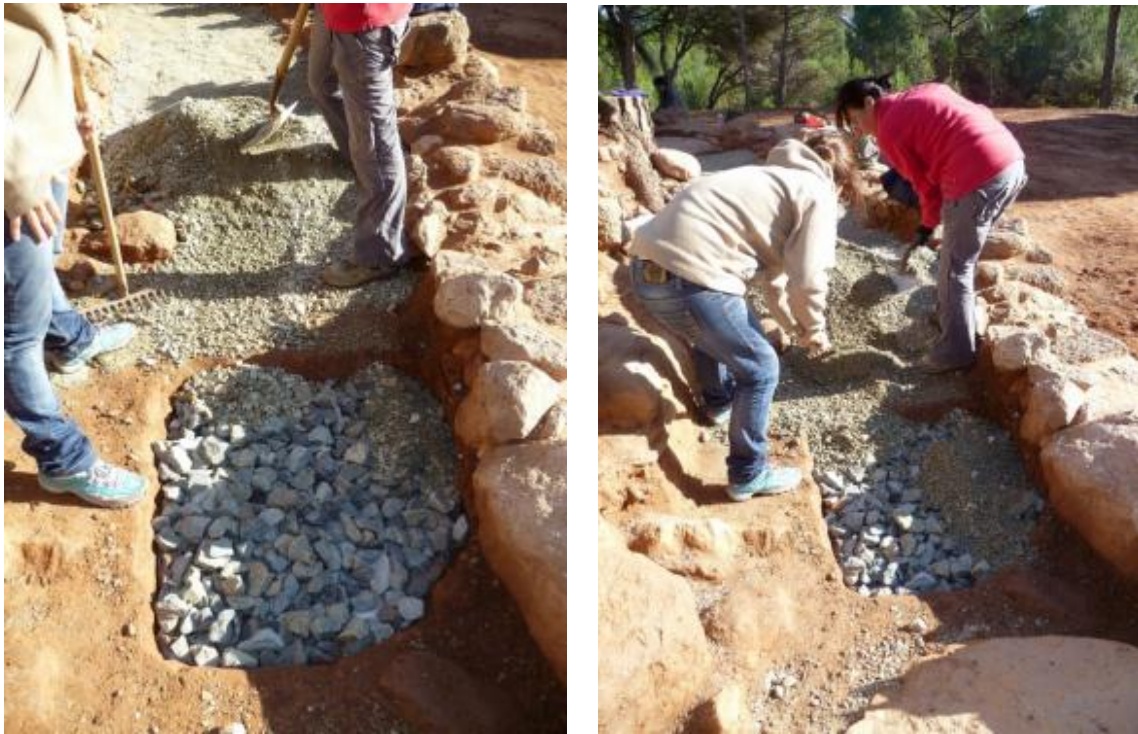
Reompliment del drenatge
