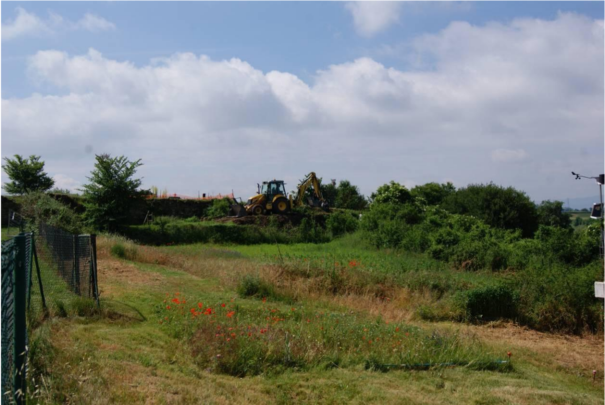
Fotografia d'inici dels treballs amb maquinària pesant.
