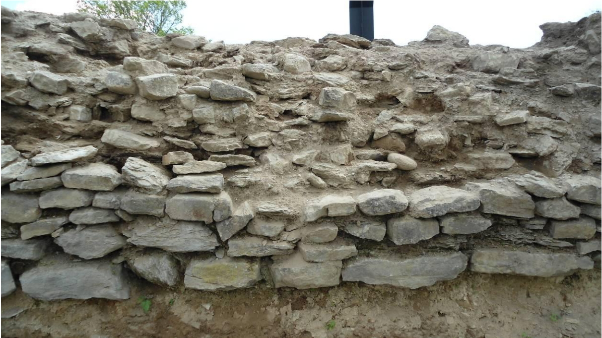
Detall del parament de la muralla amb la cara exterior i el reompliment de pedra i morter.
