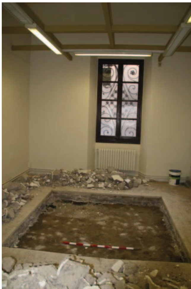
Figura 21. Vista de la Cala 2, inici dels treballs, aixecament del paviment format per la ue.2001.
