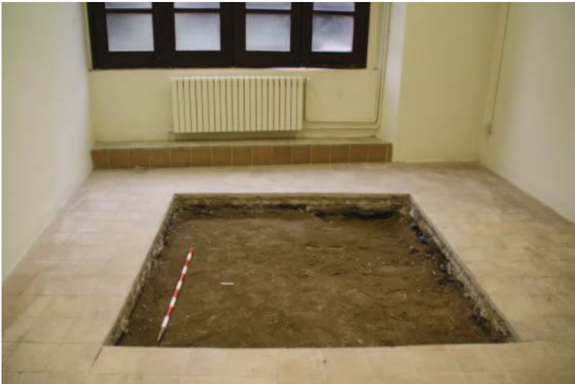
Figura 33. Obertura Cala 3, vista des de l'est, un cop aixecat el paviment actual ue. 3001.
