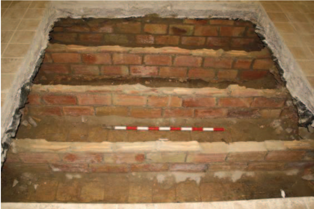
Figura 22. Vista de la Cala 2, estructura de maons formada per diverses cambres reblertes amb material constructiu ue. 2005 (rebliment ue.2006).
