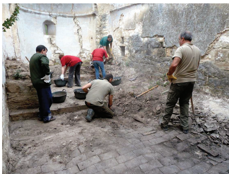
SANT PERE DE VILAMARICS (Monistrol de Montserrat, Bages). - Vistes dels treballs de neteja de runa de l'interior de l'església sota control arqueològic amb el personal i grup de voluntaris.
