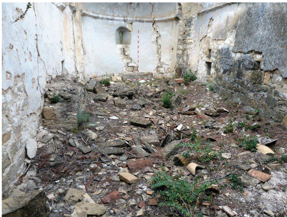
SANT PERE DE VILAMARICS (Monistrol de Montserrat, Bages). - Vista de l'estrat superficial de runa que cobria tota la nau de l'església. Està format per pedres i morter de la volta, teules, morter disgregat i altres deixalles.
