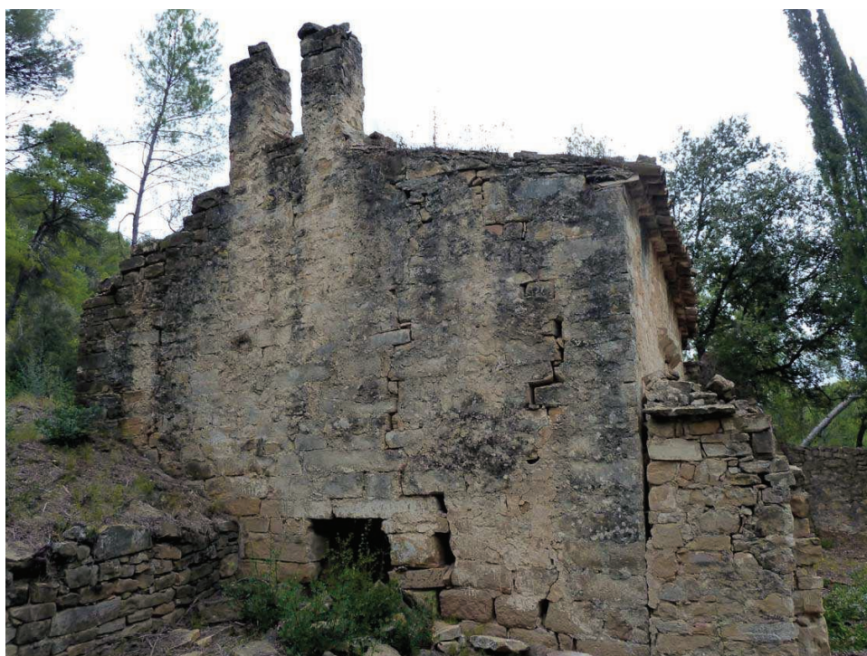
SANT PERE DE VILAMARICS (Monistrol de Montserrat, Bages). - Vista dels peus de la nau romànica de Sant Pere. S'observa el campanar d'espadanya mig desmuntat.
