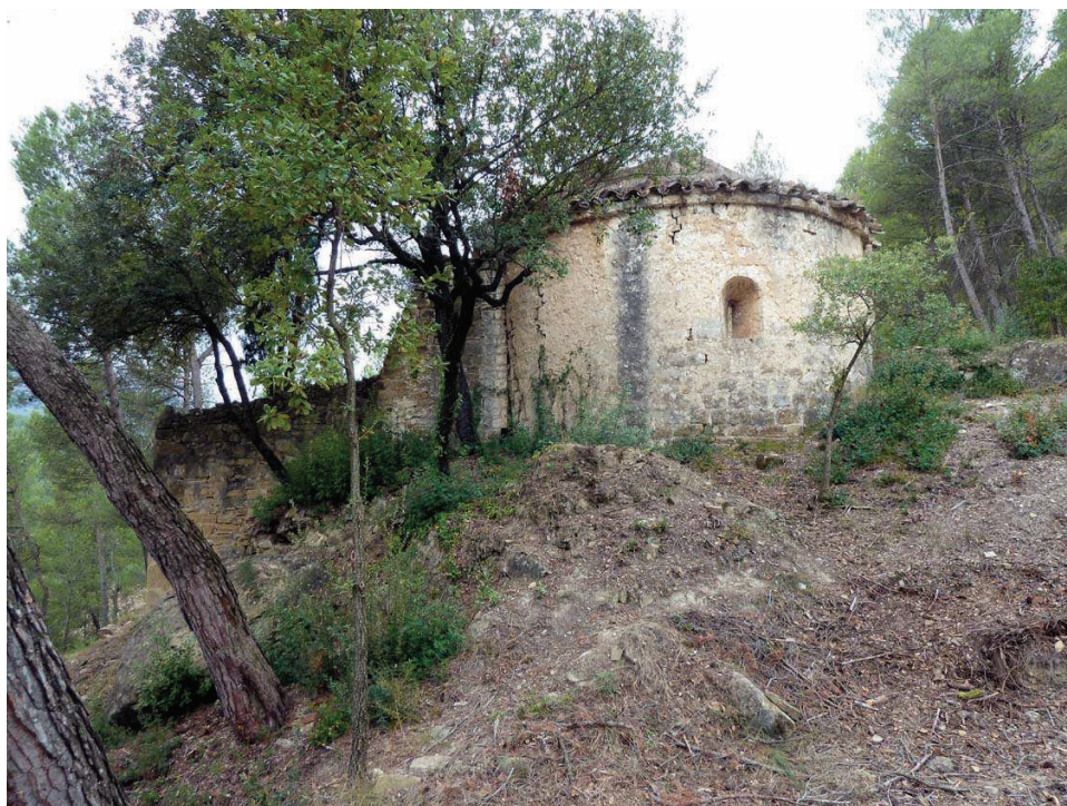
SANT PERE DE VILAMARICS (Monistrol de Montserrat, Bages). - Vista del cantó est de l'església romànica de Sant Pere. Presenta una finestra de doble esqueixada a l'absis semicircular. Així mateix es pot veure el clos del cementiri en el costat de tramuntana.
