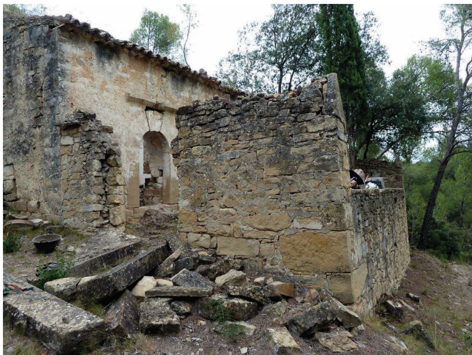
SANT PERE DE VILAMARICS (Monistrol de Montserrat, Bages). - Vista del costat de migdia de l'església on es veu els murs del clos del cementi d'època moderna, els brancals i llinda de la porta caiguts, i al fons l'entrada lateral a l'església.
