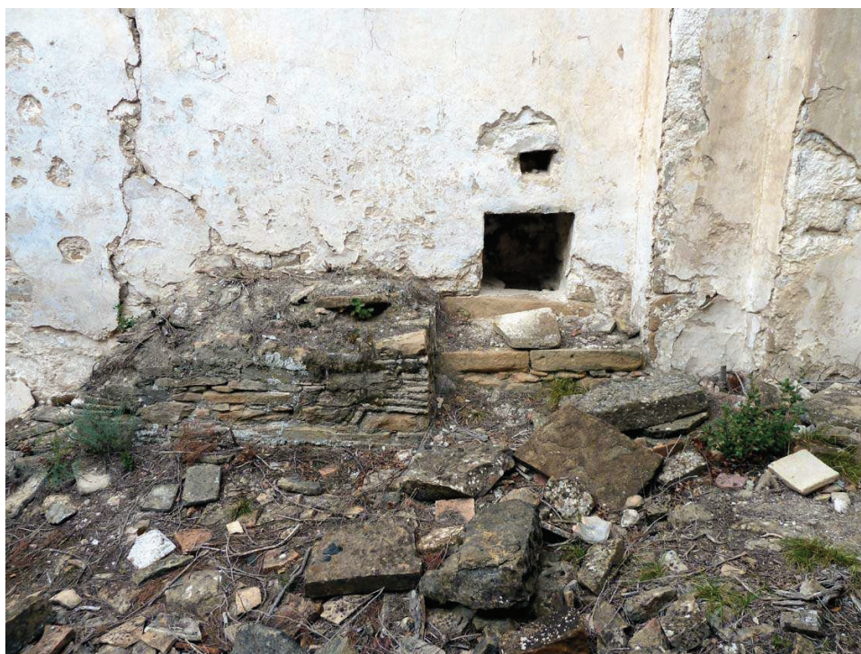
SANT PERE DE VILAMARICS (Monistrol de Montserrat, Bages). - Vista del costat nord de l'església a on s'hi emplaça la base d'un altar lateral d'època moderna. Està obrat amb pedres i rajols lligats amb morter de calç i originalment hauria sustentat un retaule o imatge de fusta desapareguda.
