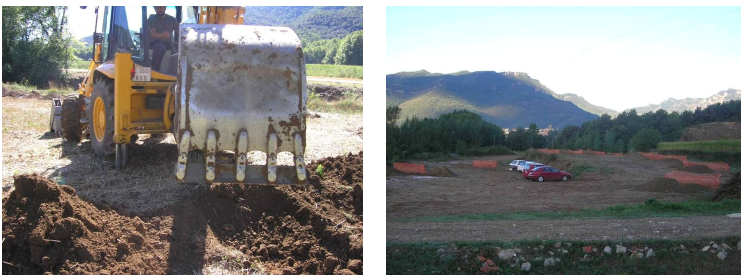
Figura 10. Sondejos: detall treballs mecànics (a) i de la distribució regular de cates (b).
