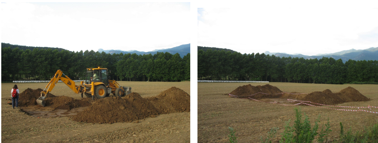
Figura 22. Vista general de l'àrea intervinguda i detall dels treballs previs d'acondicionament de l'àrea a excavar mitjançant l'extracció mecànica del nivell superficial.
