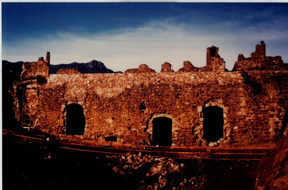
II.- L'àmbit 10.100 en fase de restauració.
