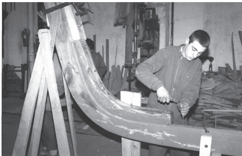
Instal·lació de la roda de proa. Drassanes Gay (Sant Feliu de Guíxols, 1996). Museu de la Pesca. Fons J. M. Vicens.
