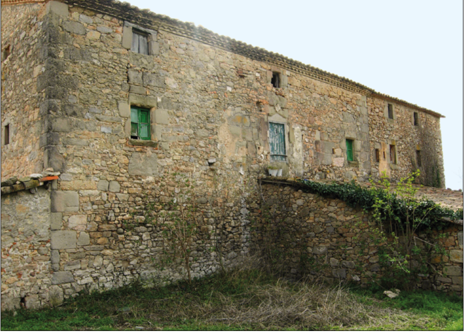
Façana de tramuntana
