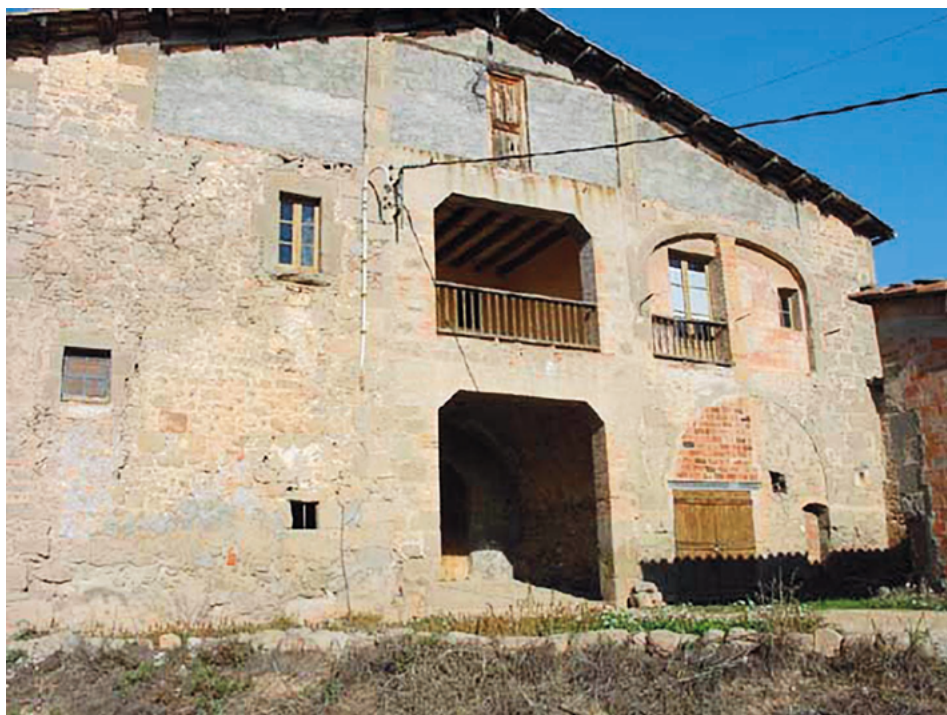
Façana de migdia
