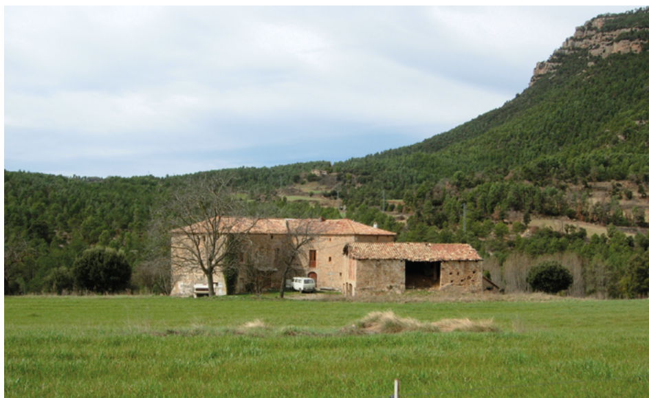
Conjunt format per la masia, coberts, pallissa, l'era i altres elements que configuren un habitatge familiar autosuficient, característic de la zona agrícola del baix Berguedà.
