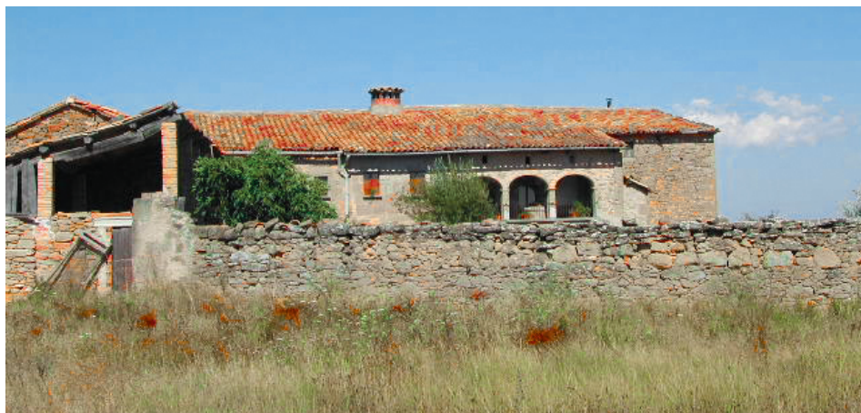
Vista general de la façana de migdia
