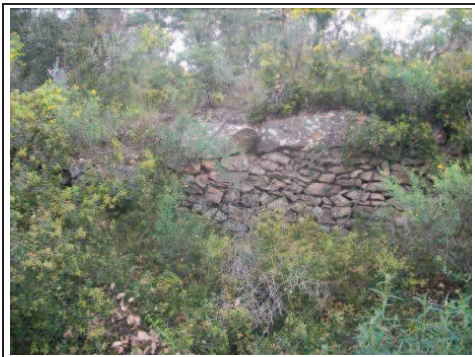
Foto 23. AP 2. Marge de pedra seca en direcció AEG 5.
