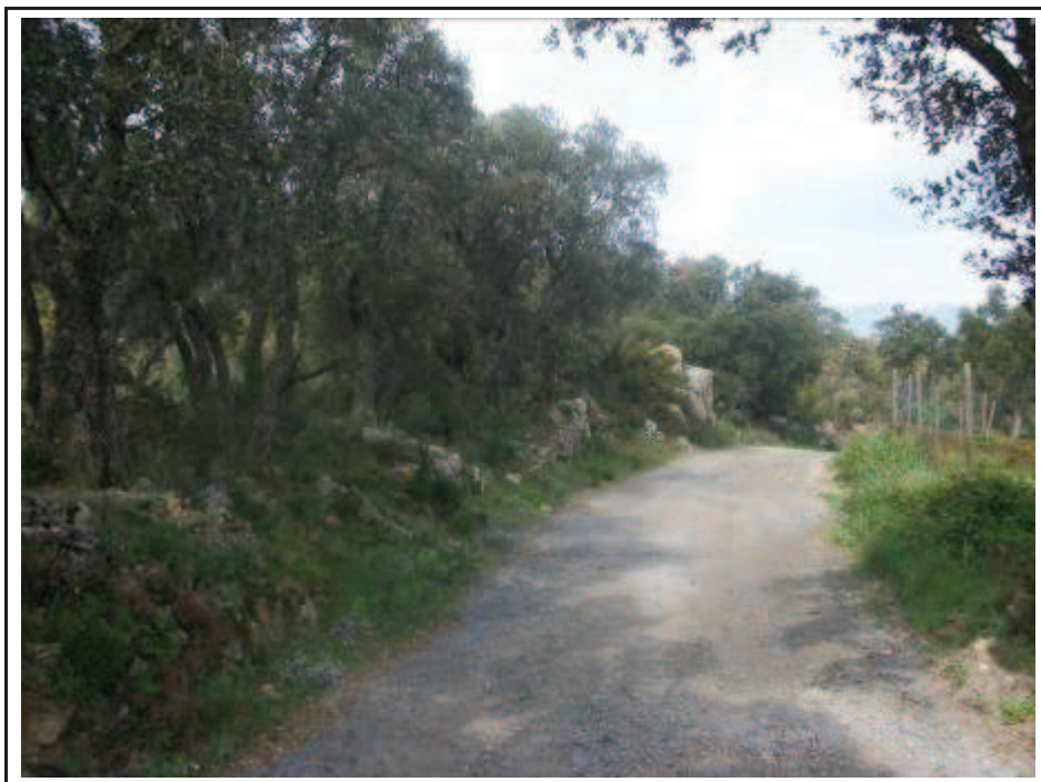
Foto 25. AP 2, Camí d'accés existent a l'AEG 4.
