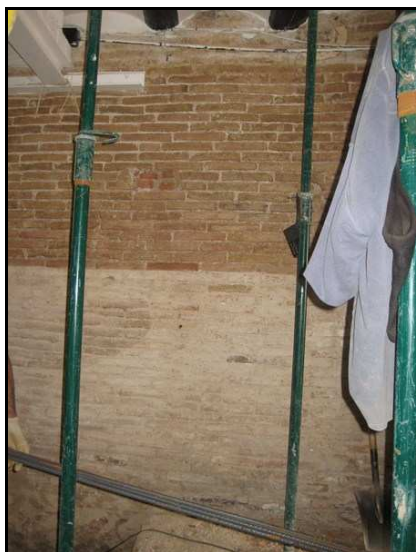
Detall de la paret oriental del primer àmbit. S'observa com està construïda amb maons massissos.
