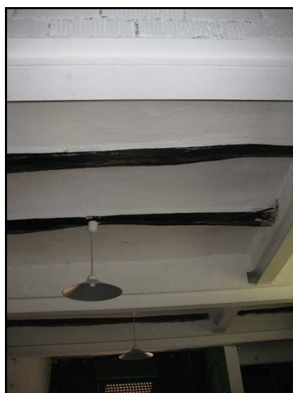
Imatge del sostre del primer àmbit
