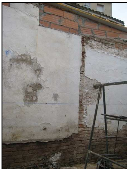
Paret NE del tercer àmbit
