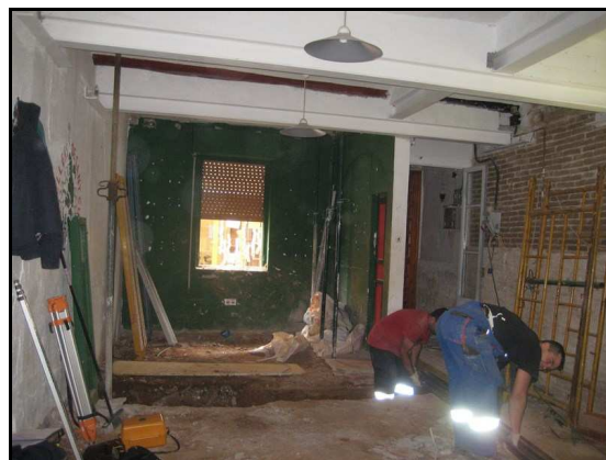
Vista NW de l'àmbit 1
