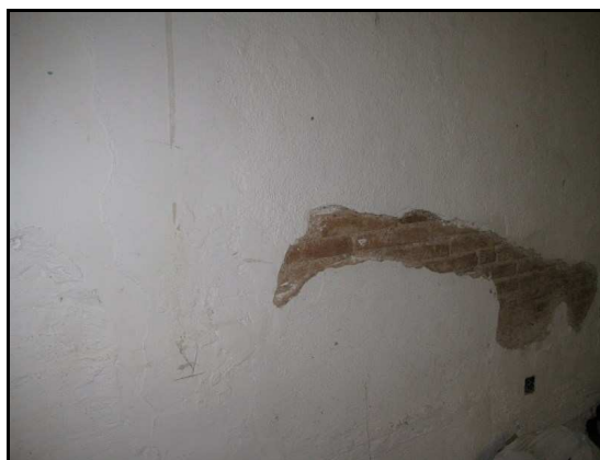
Detall de la paret occidental del primer àmbit. S'observa com també està construïda amb maons massissos.
