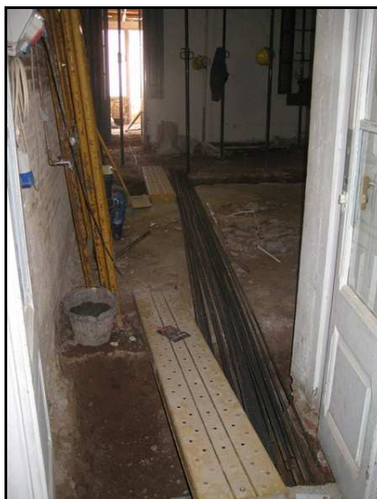
Vista SE de la Cala 200 des de l'entrada de l'edifici
