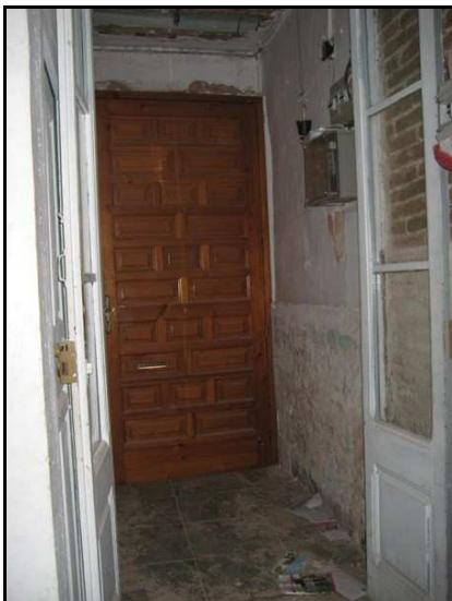
Imatge de l'entrada a l'edifici des del primer àmbit. S'observa a la paret de la dreta els maons massissos.
