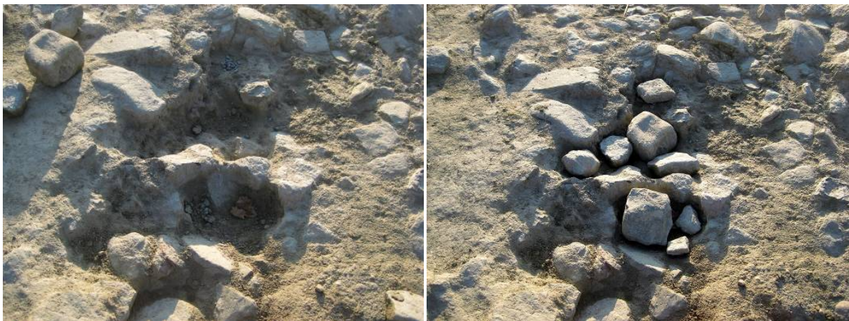
Rebliment amb pedres abans de posar morter
