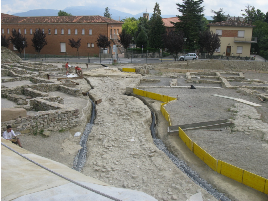
Vista general amb els drenatges
