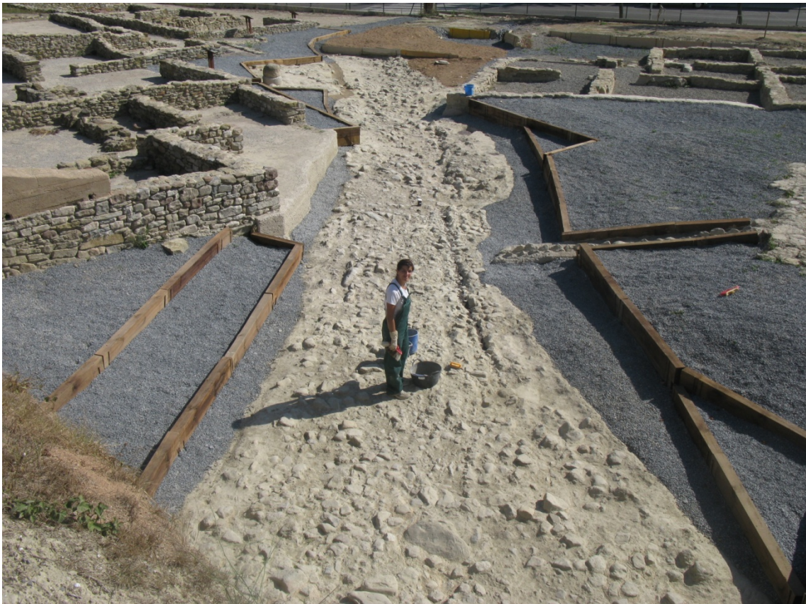
Treballs de consolidació
