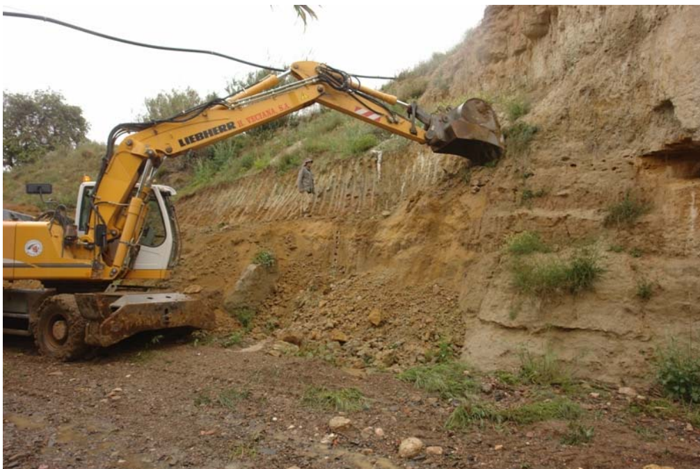
Figura 6.- Vista dels primers treballs de la campanya. Una màquina excavadora que elimina els sediments que cobreixen la unitat estratigràfica II de la Mina.
