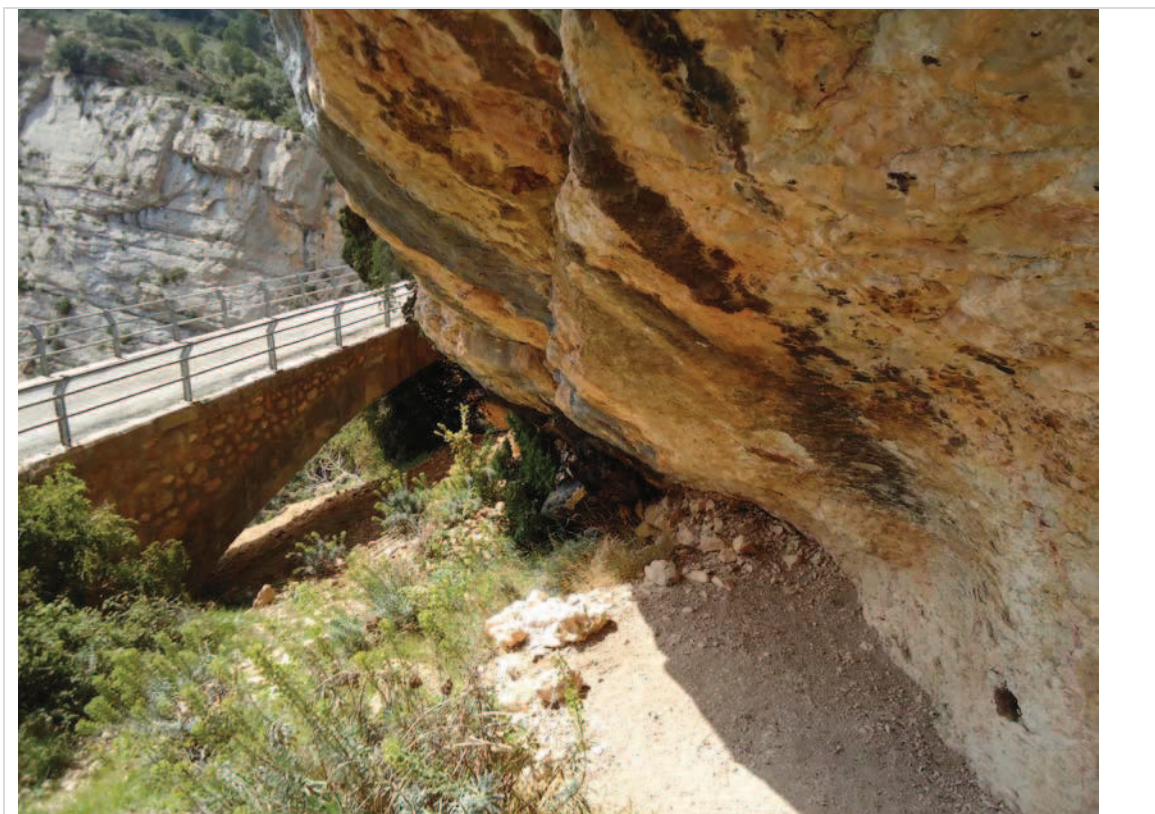
Fig.2. Vista lateral de l'abric EPN1.
