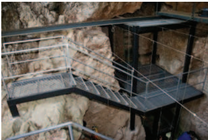
Figura 5: actualment dins el Sector Alfa (o Pou Corominas) s'aixeca una bastida per protegir-lo de les esllavissades.
