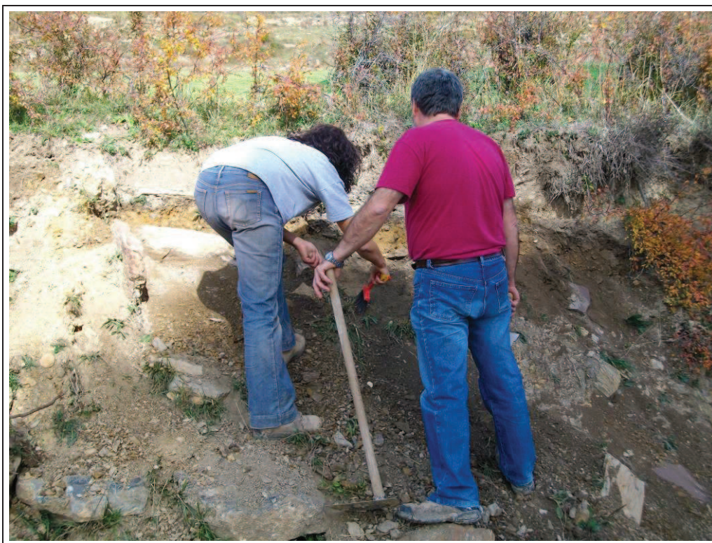
Foto 10: UF 2. Inici dels treballs de delimitació
