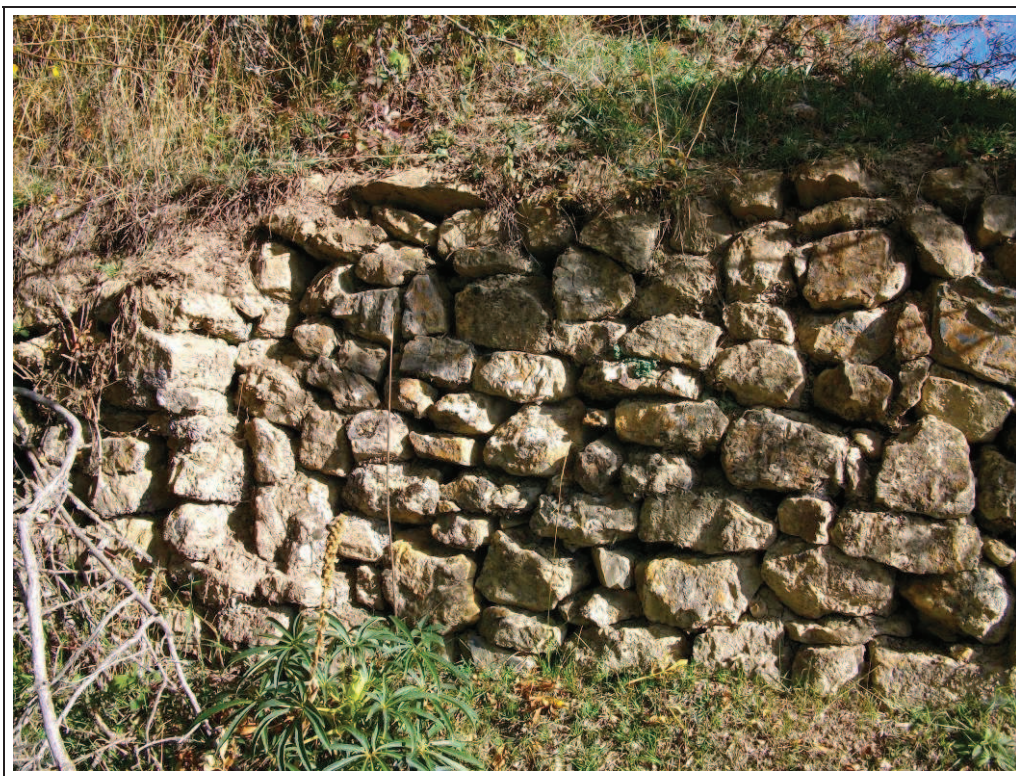
Foto 33: Vestigis del camí antic. Detall d'un dels murs de contenció
