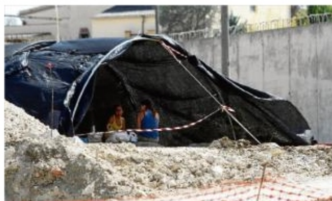
Les excavacions es duen a terme en un total secretisme, sota una lona negra, als terrenys adjacents al Camp dels Ninots. carles colomer
