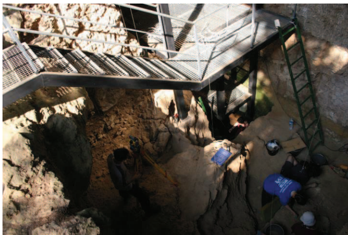
Figura 24: Vista del nou sistema d'accés al sector Beta des de la plataforma metàl·lica que varem instal·lar a finals de l'any 2009.
