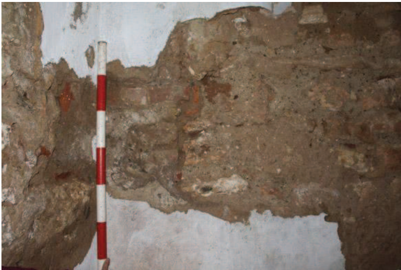
18. Vista puntual d'EM4 obra de maons, integrada en EM3 i en el que es veu amb claredat com se li recolza EM5.
