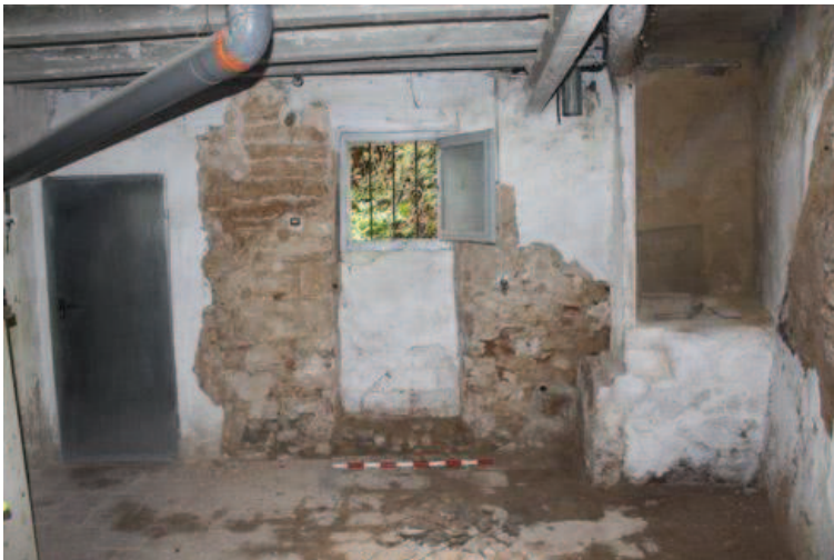
15. Vista de l'estructura EM2, en la que s'aprecia l'antiga porta tapiada que comunicava amb l'hort i el replà de l'escala.
