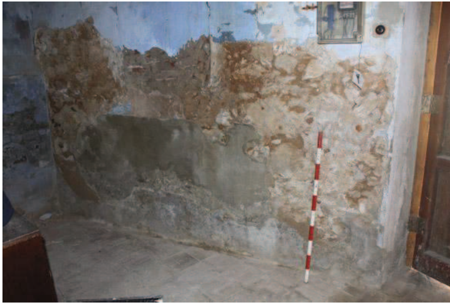
22. Tram de'EM8 a l'àmbit 1. E pot apreciar una finestra tapiada i com l'obra de maçoneria és idèntica a les d'EM3, 6 i 7
