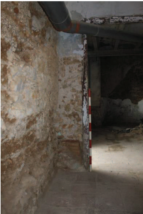
23-24. Imatge superior es veu el parament d'EM 9 amb l'obertura de la porta. A la dreta es veu el brancal obrat amb maons, pedra i guix.
