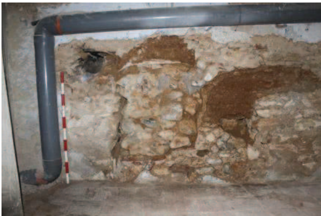
8. Vista del mur de tàpia i de la cantonera de llevant. Es pot apreciar l'obra de maçoneria i la seva relació amb la tàpia.
