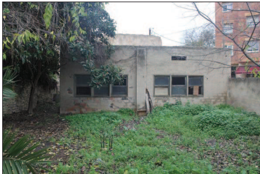
5-Vista de l'hort i de l'edificació annexa al sud
