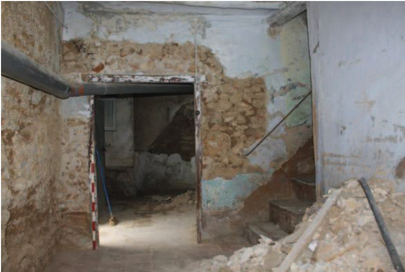
23-24. Imatge superior es veu el parament d'EM 9 amb l'obertura de la porta. A la dreta es veu el brancal obrat amb maons, pedra i guix.
