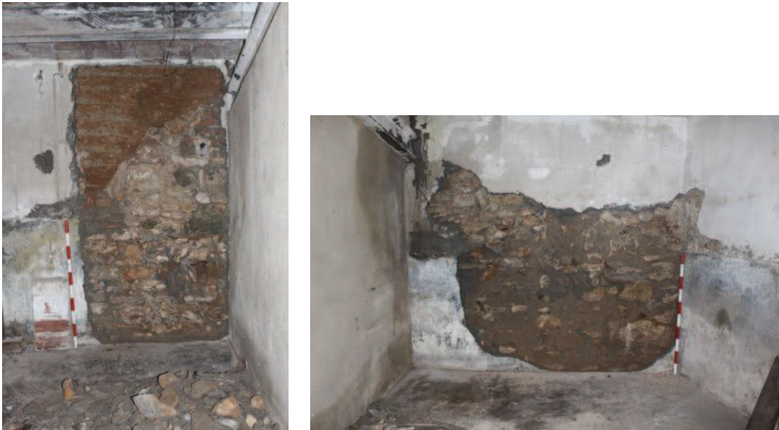
12-13. Sondejos exteriors en el que s'aprecien els arranjaments moderns.
