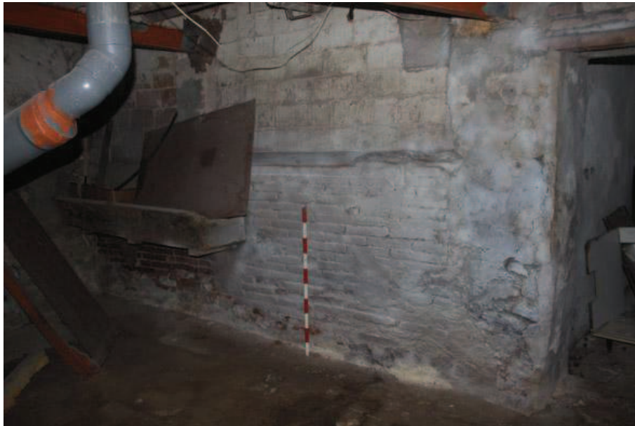
25. Mur EM10 obrat amb maons massissos amb doble disposició, plans a la part inferior i de cantell a la superior
