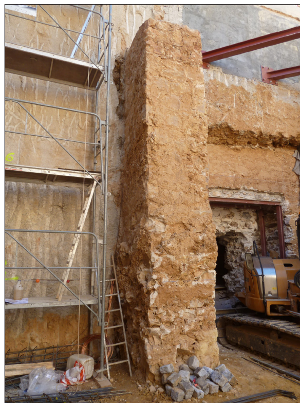
Figura 17. Vista del contrafort exterior de la nau sota el baluard de Sant Carles, identificat en el transcurs de l'obertura del pou per al nucli d'instal·lacions. Foto: Josep M. Vila.
