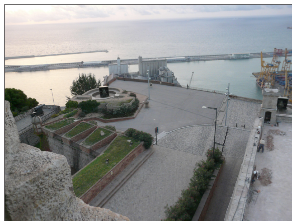
Figura 15. Vista de la part superior del baluard abans de l'inici de la intervenció. Foto: Josep M. Vila.
