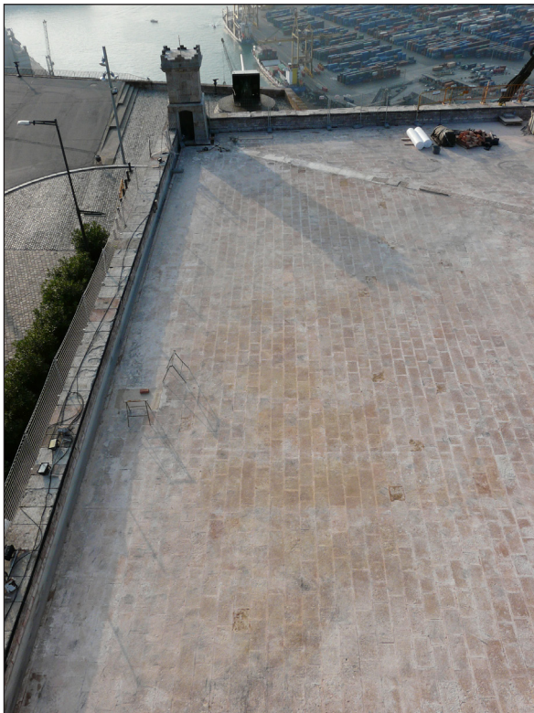
Figura 12. Vista general del paviment original del terrat. Foto: Josep M. Vila.
