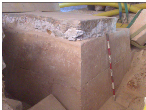
Figura 6. Detall de la cantonada entre el flanc i la cara de la part dreta del baluard occidental del primitiu fortí de Montjuïc aparegut durant la intervenció del 2015. Foto: Òscar Trullàs (Arqueòlegs.cat).
