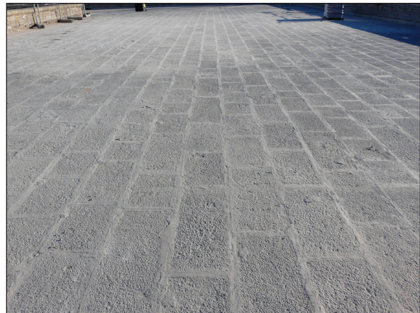
Figura 13. Detall del paviment format per carreus de pedra disposats en filades. Foto: Josep M. Vila.
