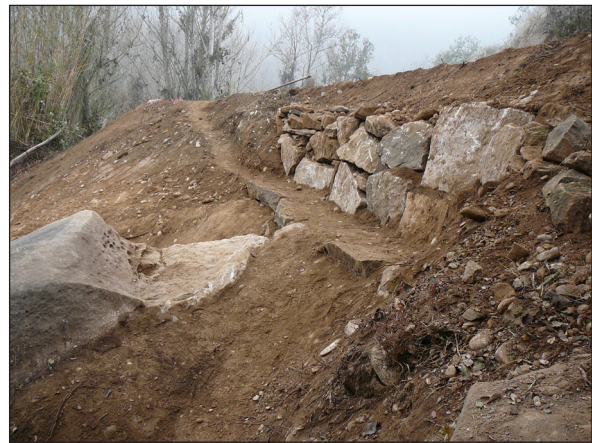
Figura 13. El talús format entre la part superior de la roca i la pista d'accés va permetre la construcció d'un petit camí d'accés a la roca.
