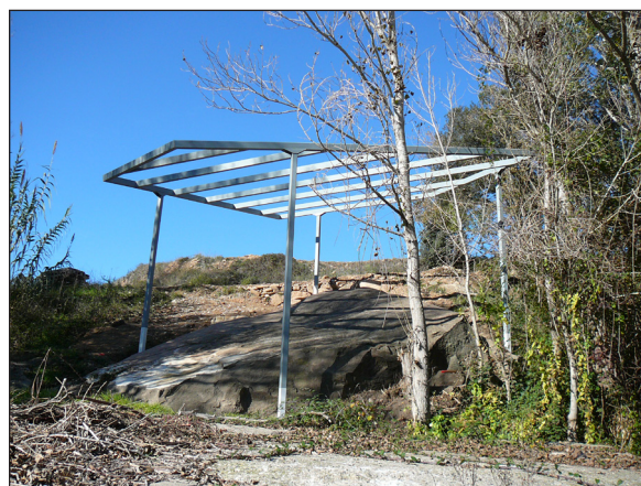
Figura 25. Estructura muntada vista des del riu.
