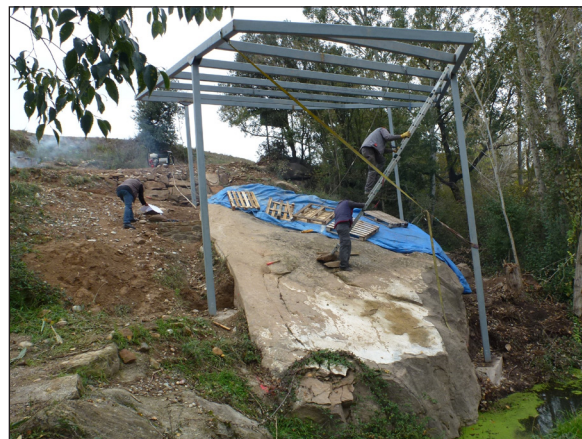
Figura 24. Muntatge de l'estructura. Es pot observar la sabata del pilar número 3 a tocar del canal d'Anyà.
