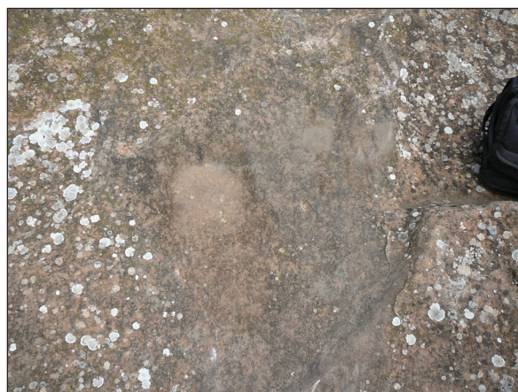
Figura 31. Detall dels resultats de la segona intervenció realitzada amb raspall i biocida.
