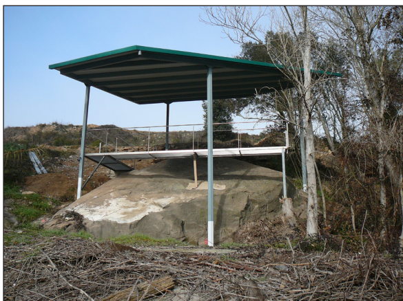
Figura 26. Coberta ja instal·lada i muntatge de la passera de circulació/contemplació.
