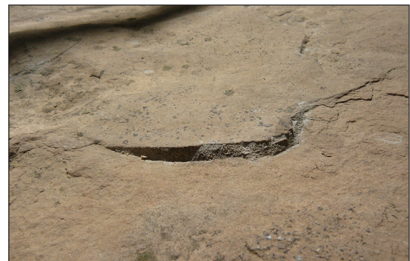
Figures 44 i 45. Detall de la darrera fase, fixació de totes les fissures amb morter de calç per evitar futurs desplaçaments.
