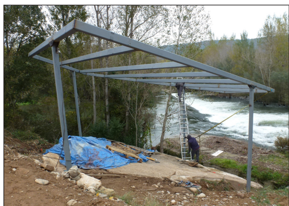
Figura 23. Instal·lació de pilars i estructura de coberta vista des del camí.
