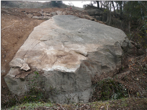
Figura 15. Imatge final de la delimitació de la roca. A la part inferior de la roca s'observen els grans trencaments ocasionats per les voladures realitzades durant la construcció de la resclosa.
