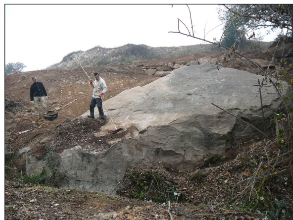
Figura 14. Treballs finals de la retirada de la brossa vegetal superficial.
