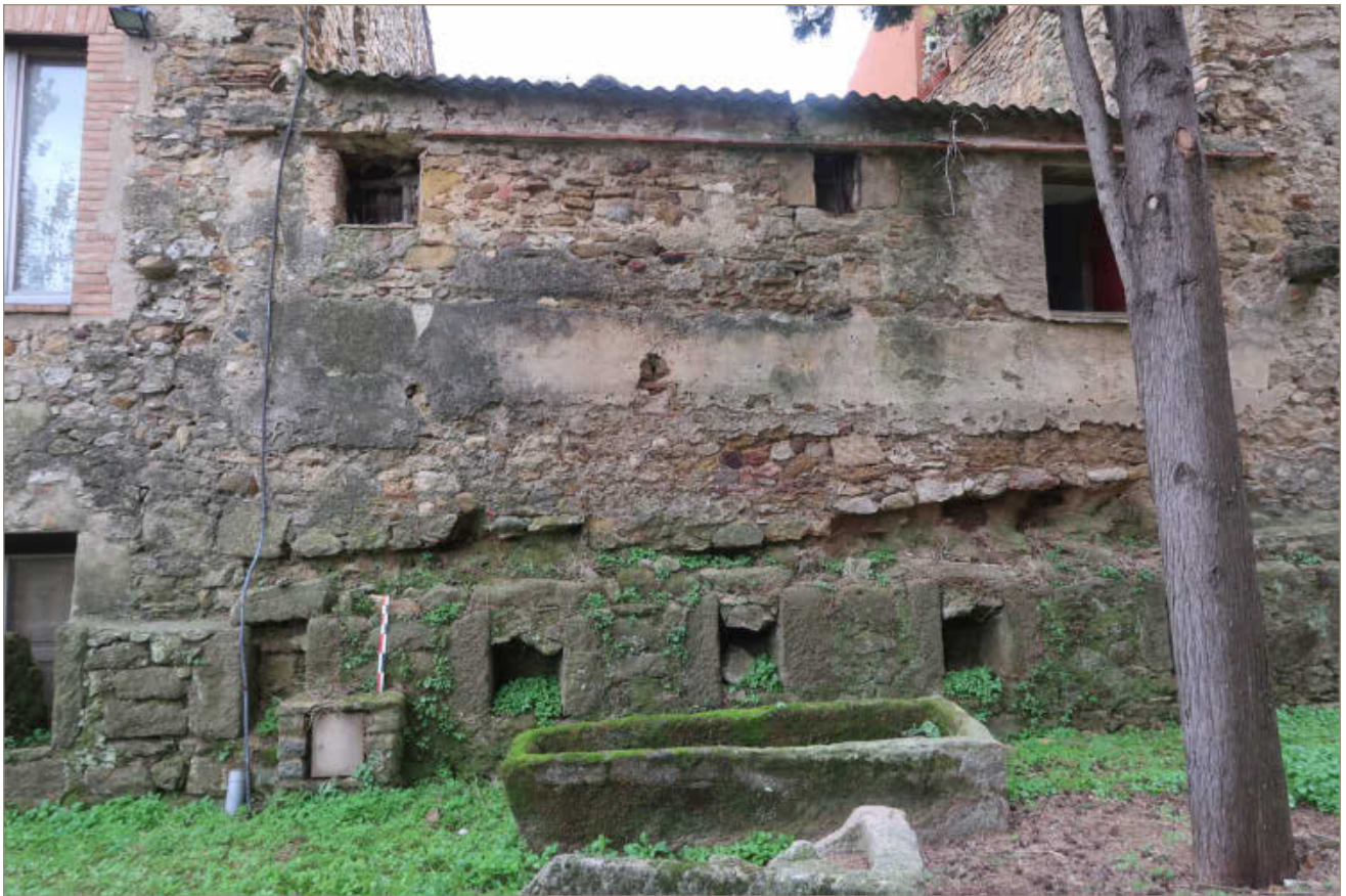
Figura 1. Façana posterior vista des del cementiri parroquial.
