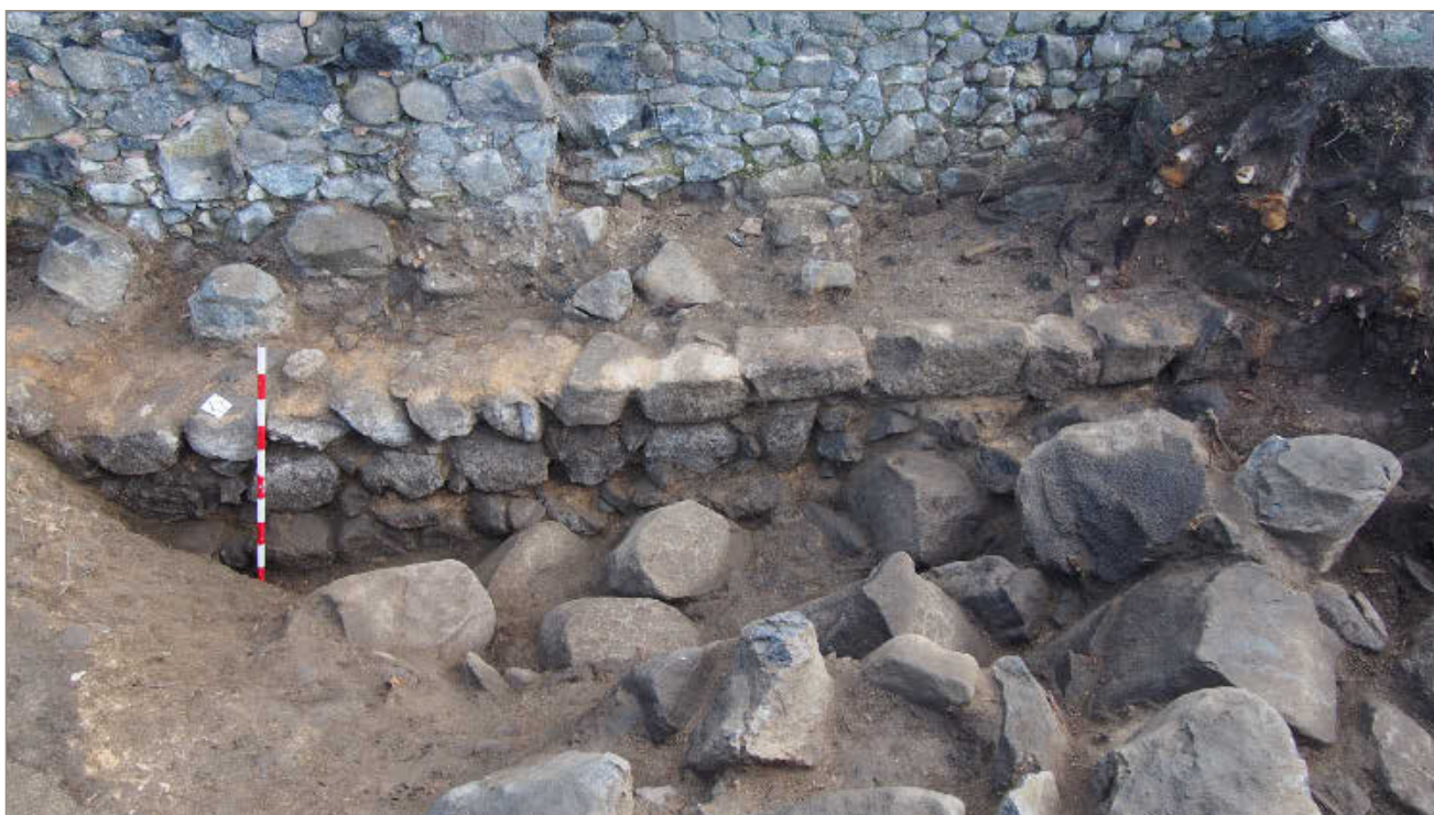
Figura 1. Banqueta de fonamentació de la muralla est del segle XIV construïda sobre el subsòl de basalt en el sector 22.
