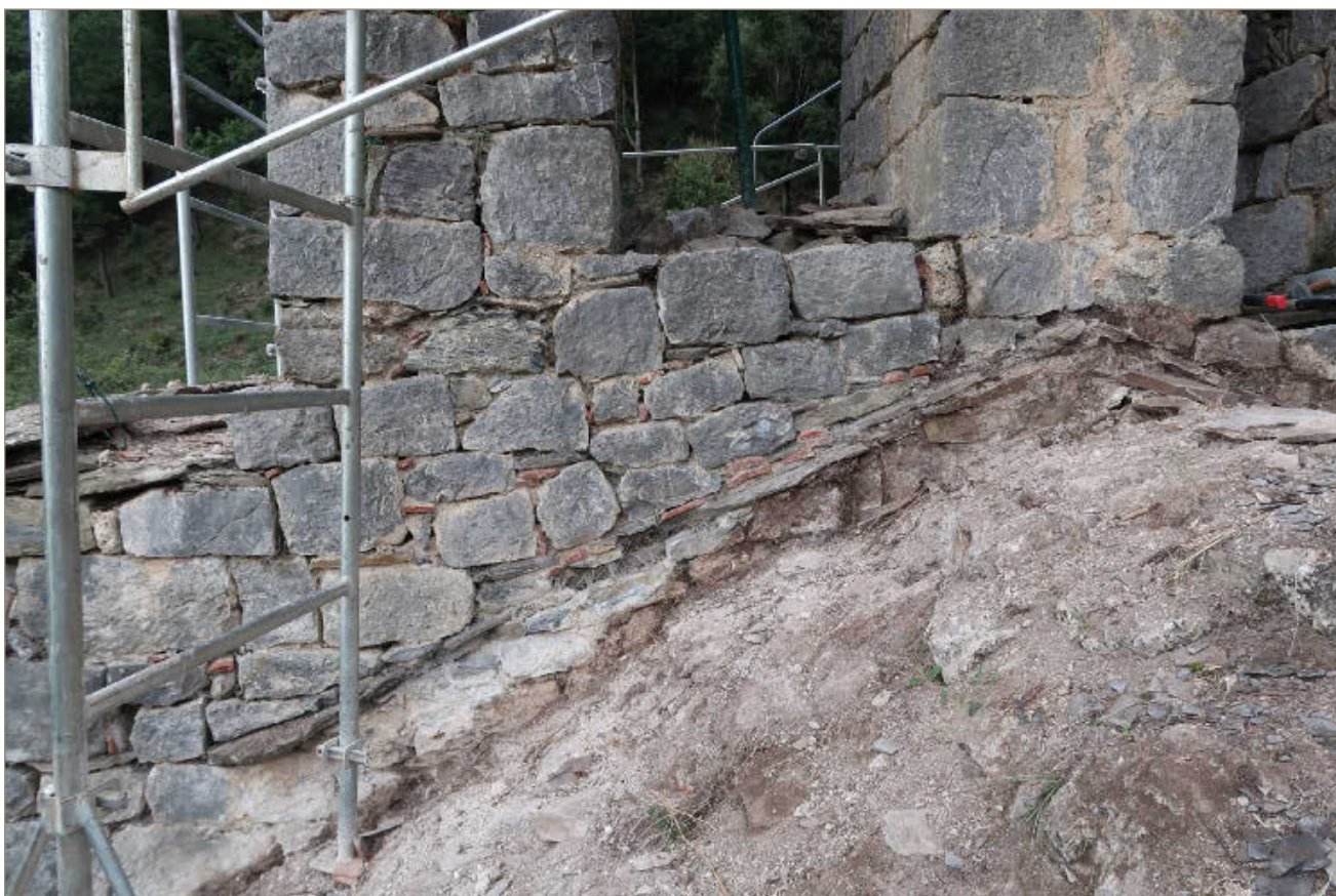
Figura 2. Empremta del nivell de l'enllosat o trencaigües original al vessant sud.
