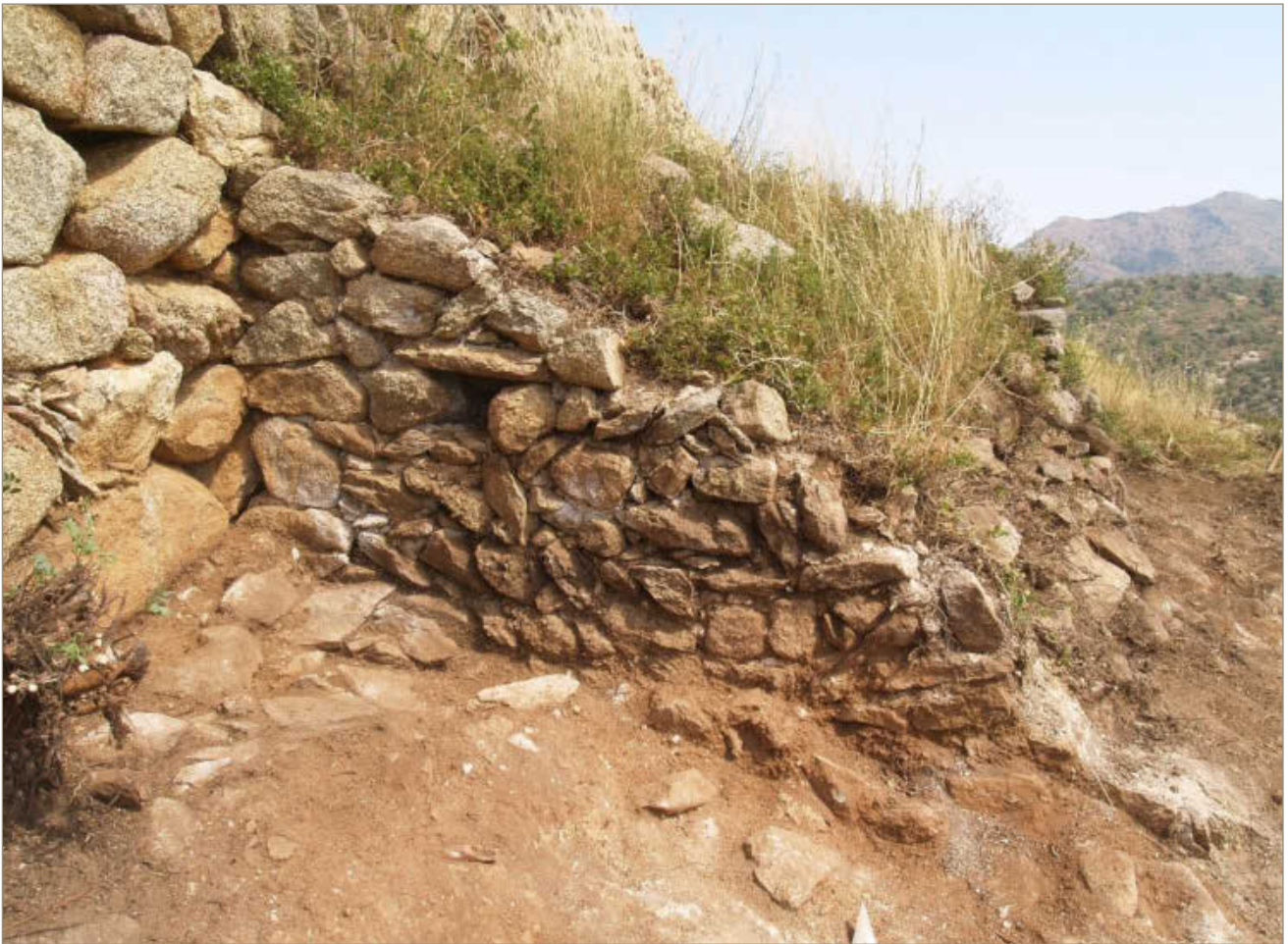
Figura 2. Detall del parament occidental de la Torre 6.
