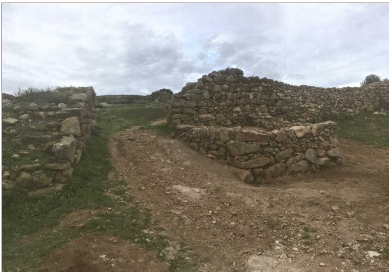
Figura 2. Vista general de la torre, després de la intervenció.
