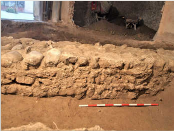
Figura 2. Vista de la cara interior de la muralla baix medieval de Peralada.
