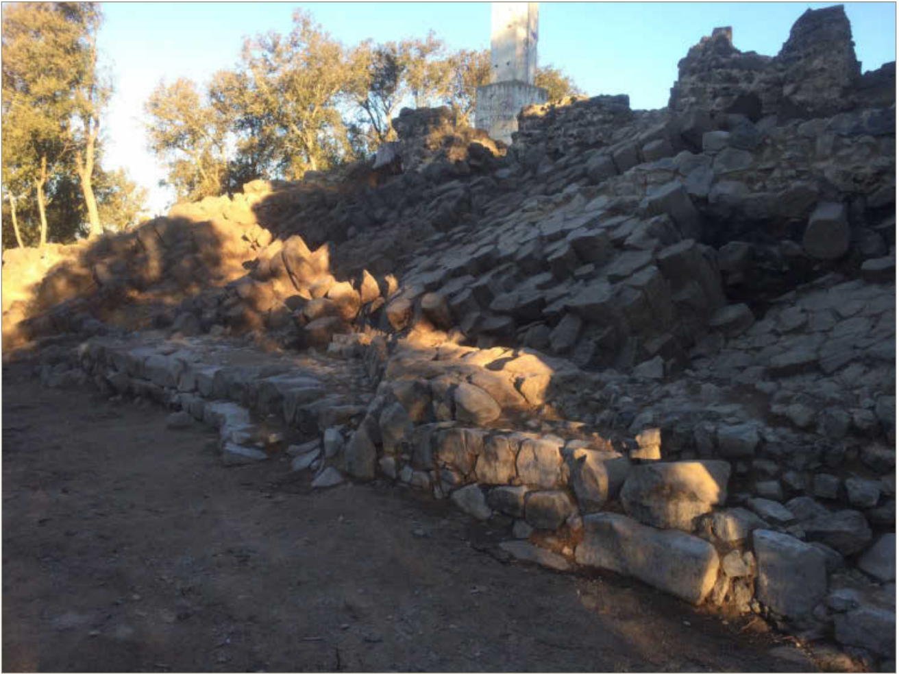
Figura 2. Vista general de part del sector sud del castell, després de la intervenció.
