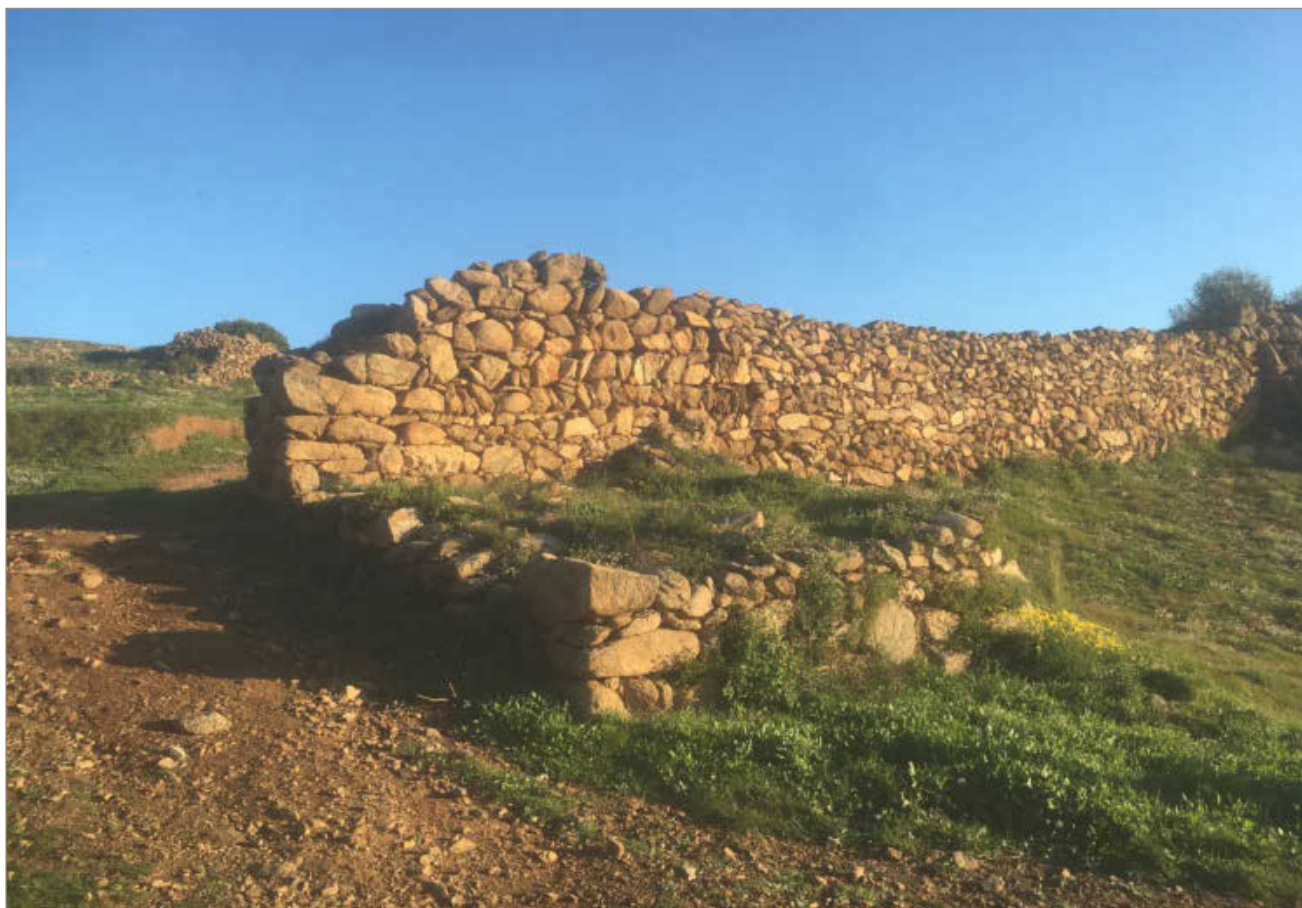
Figura 1. Vista general de la torre, abans de la intervenció.
