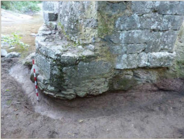
Figura 2. Detall del pilar i l'estrep.
