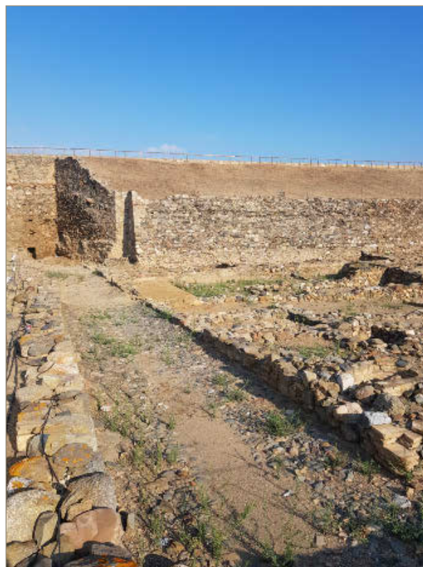
Figura 2. Vista general del carrer d'en Ganyut un cop finalitzats els treballs.
