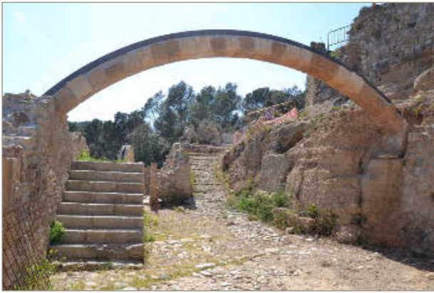
Figura 2. El gran arc del pati d'armes, després de la seva reconstrucció. Al fons, es veu un segon arc, que també ha estat restaurat. A la dreta, ajuntat final dels blocs.
