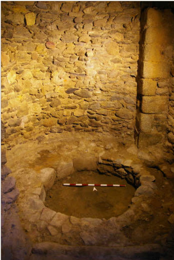
Figura 2. Vista de la banqueta de fonamentació documentada a l'interior de la torre. Als fons de la imatge i a mà dreta es pot veure la cantonada sud-oest de la muralla i de com s'integra a la construcció posterior de la torre.
