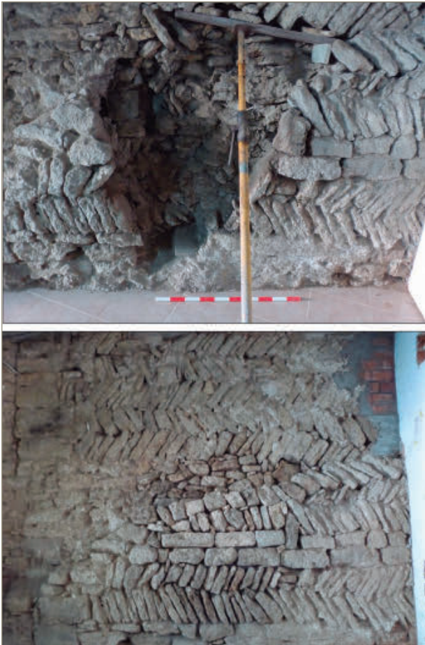
Figura 2. Aspecte de la paret mitgera entre Can Paulí i Can Xueta, avui integrada a la sala de recepció de materials del Museu, abans i després de refer el parament.
