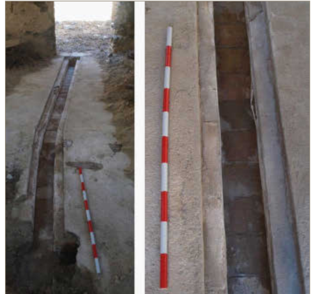
Figura 2. Vista general i detall de la canalització localitzada del Trull d'en Meranges.
