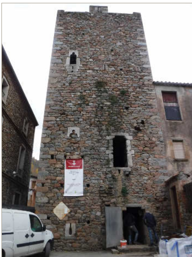
Figura 1. Façana principal de la torre de Recs (novembre 2019).
