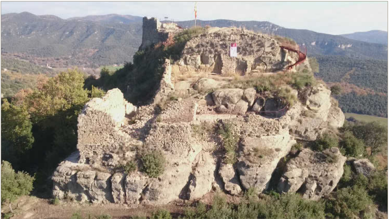
Figura 2. Vista aèria del recinte sobirà del castell d'Hostoles. A la dreta de la imatge es pot observar la nova escala d'accés, l'original va desaparèixer fa temps en erosionar-se la base, que permet connectar les dues plataformes on s'assenta aquest sector del castell.
