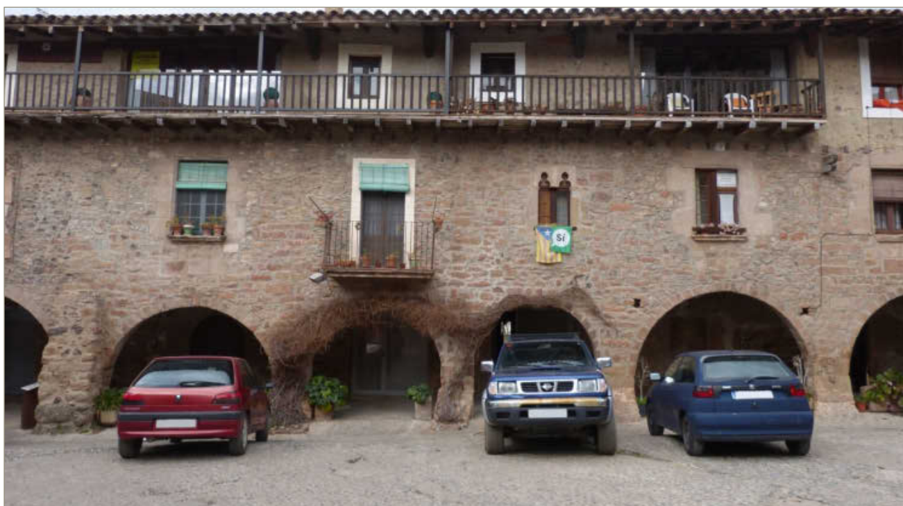
Figura 2. Vista frontal de l'edifici intervingut. Destaca la presència d'una finestra biforada amb el mainell perdut.
