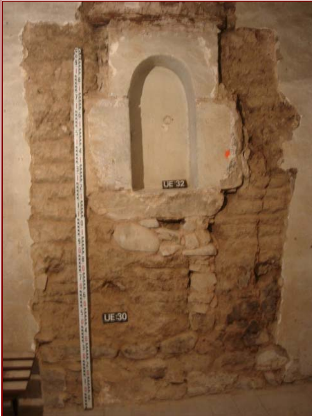
Foto 107. Cala 14. Detall de la finestra UE 32 després del seu repicat i parament de tapia UE 30.
