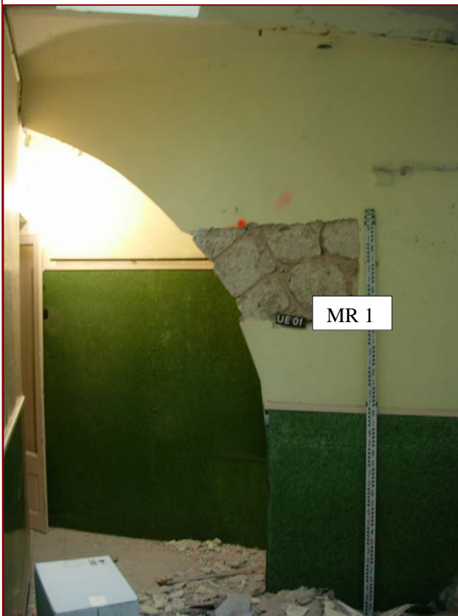
Foto 76. Vista general de la cala 1. Arc UE 01.
