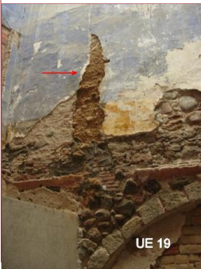
Foto 112. MR 20. Restes de mur de tàpia assentat a l'arc medieval UE 19.
