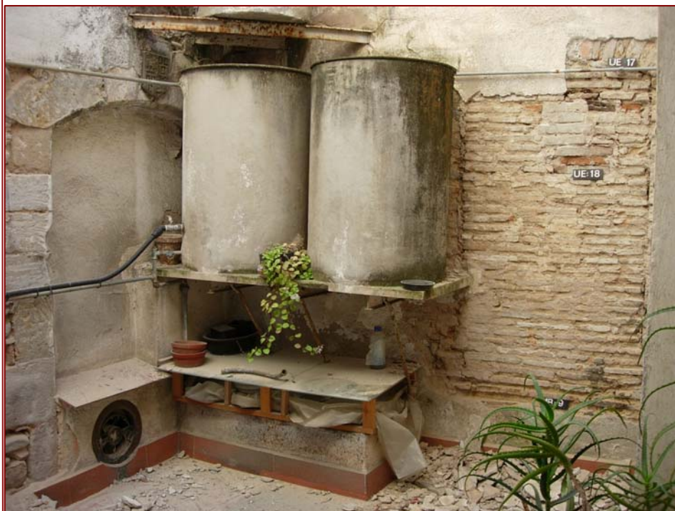
Foto 96. Cala 8. Cantonada entre les estructures muràries MR 21 i MR 9.
