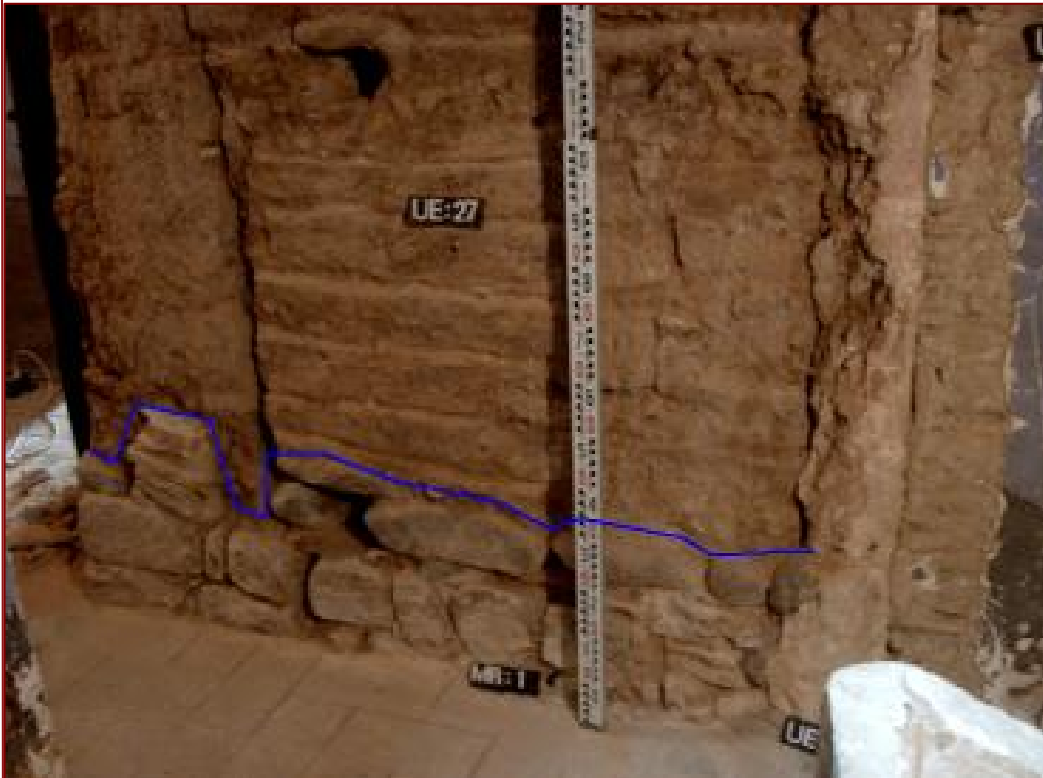
Foto 103. Cala 13. MR 1. Detall del coronament del parament UE 276 i del parament de tàpia (UE 27) del casal dels Vilatorça.
