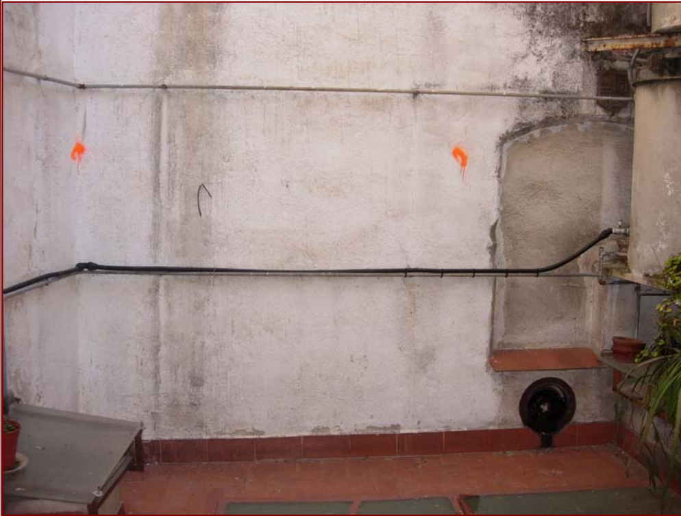
Foto 93. Cala 6. Estructures muràries MR 8 i MR 21 abans del seu repicat.
