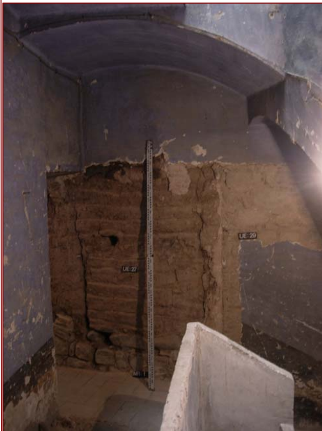
Foto 100. Cala 13. MR 1. Vista general del mur de tàpia medieval UE 27.
