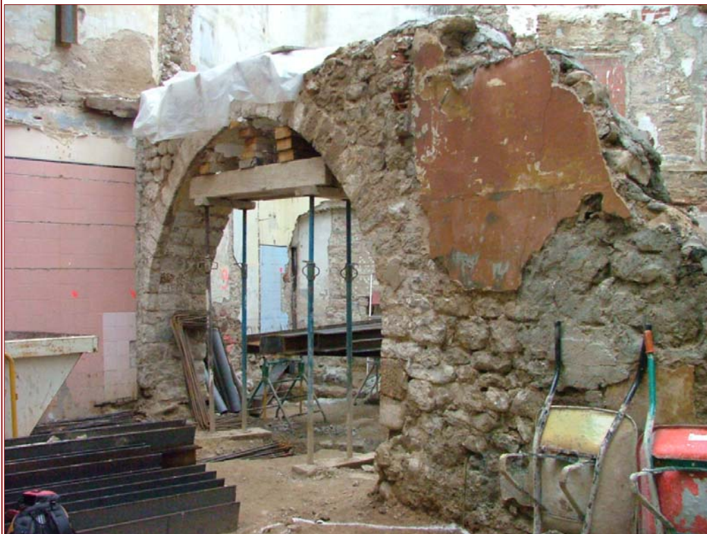
Foto 72. Arc UE 01 vist des del pati (Àmbit 2), un cop enderrocades les estructures internes de les finques.
