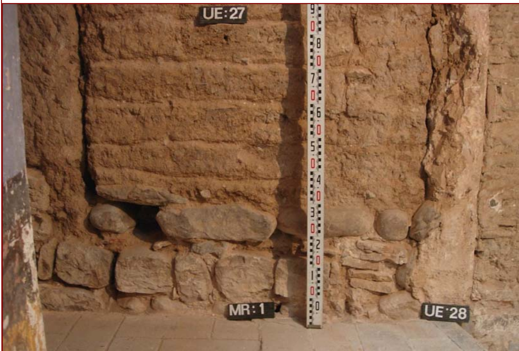
Foto 104. Cala 13. MR 1. Detall del coronament del parament UE 276 i del parament de tàpia (UE 27) del casal dels Vilatorça.
