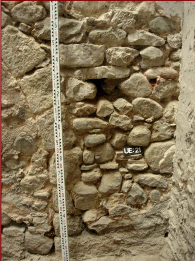
Foto 87. Cala 11. Vista del parament UE 21.
