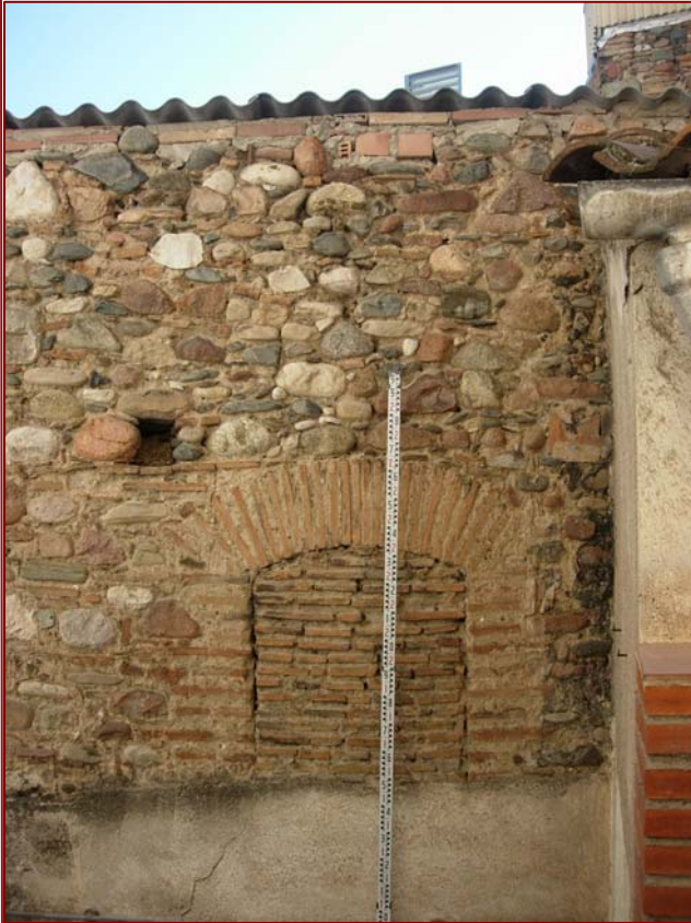
Foto 99. Cala 8. MR 9. Finestra UE 277 tapiada pel parament UE 278.
