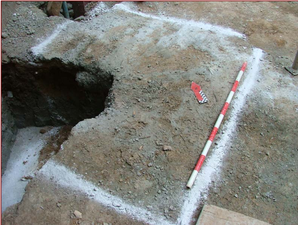
Foto 69. Forat d'ascensor. Vista general inicial
