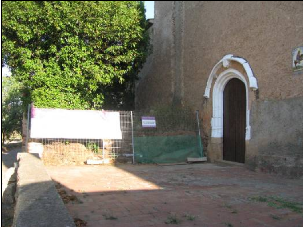
Zona on s'havien de desenvolupar les obres.
