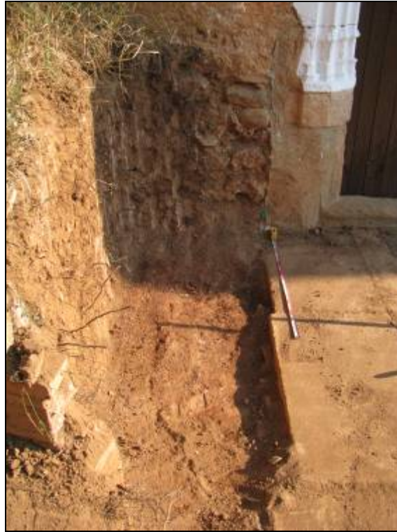
Obertura de la rasa 1.
