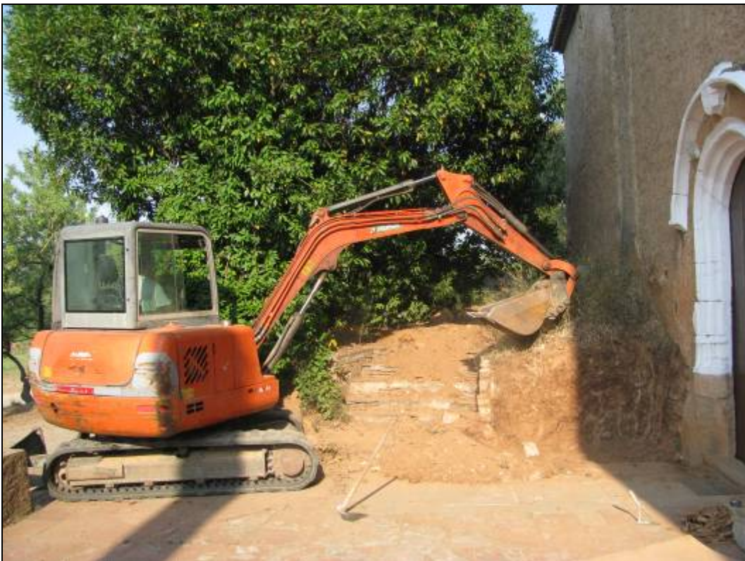
Obertura de la rasa 1.
