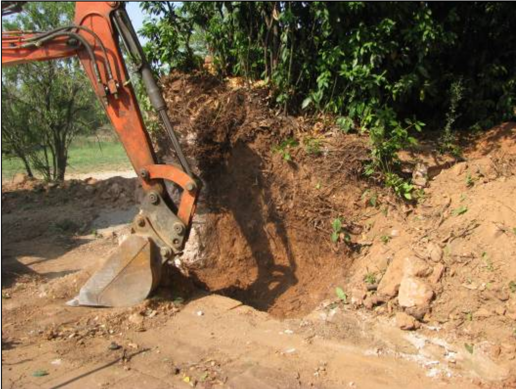
Obertura de la rasa 2.
