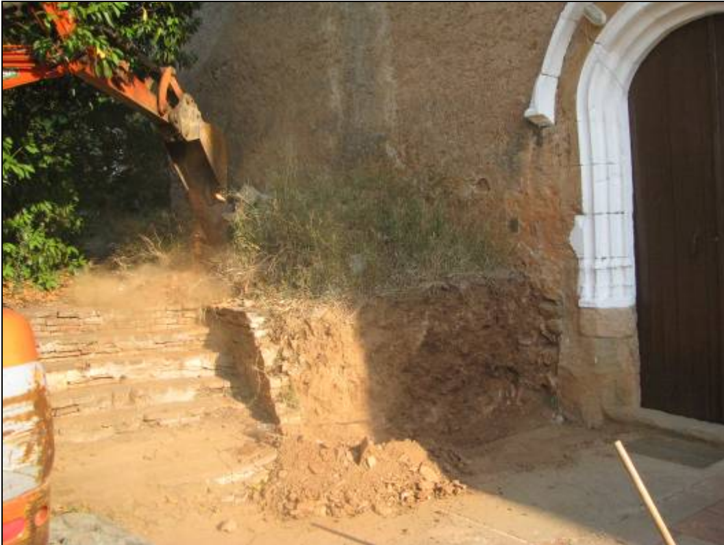
Ampliació del talús.
