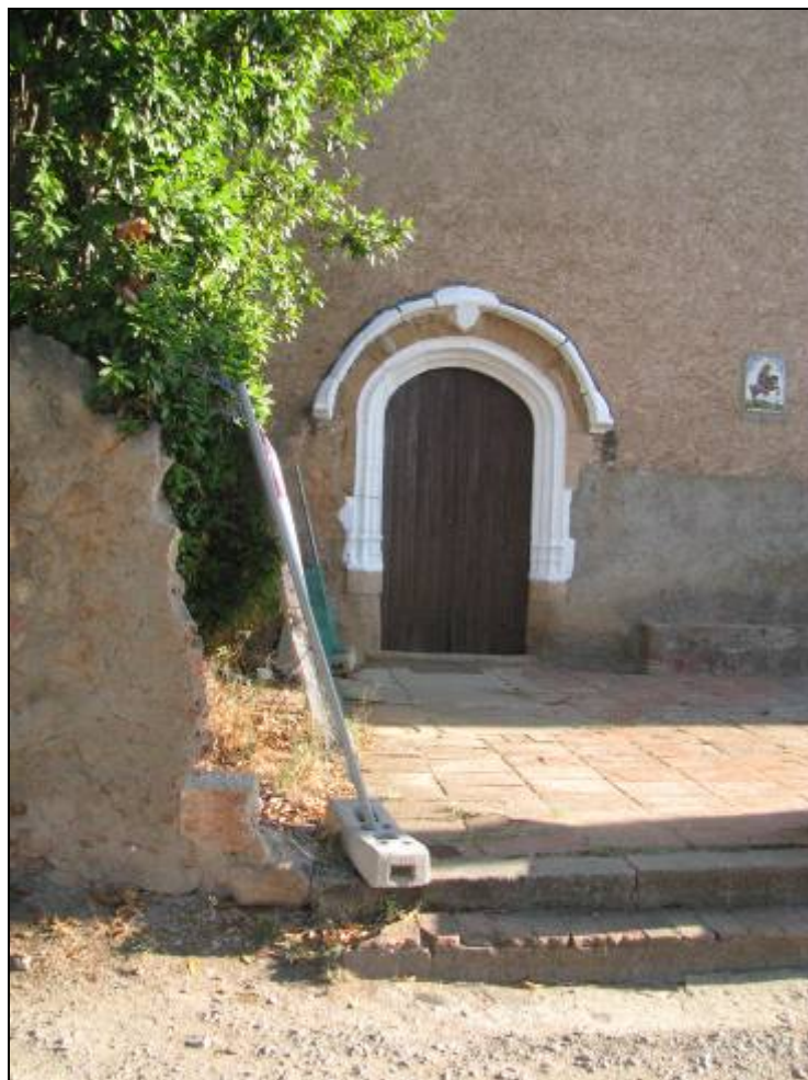
Zona on s'havien de desenvolupar les obres.
