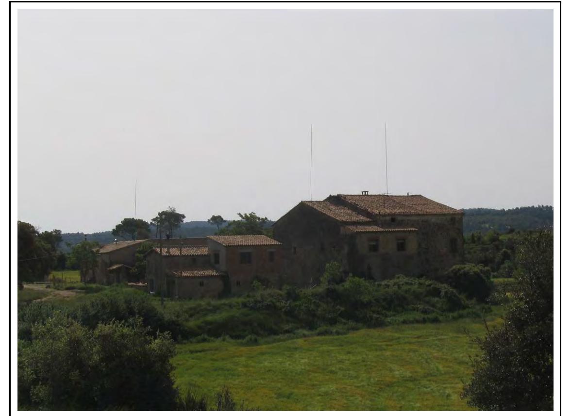
Foto 27: ED. 3, vista general de Casa Ponça des del nord.
