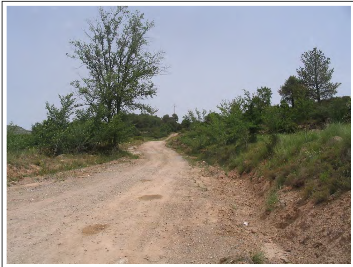
Foto 1: A.P. 1, inici del camí de Cal Pallot des del sud.
