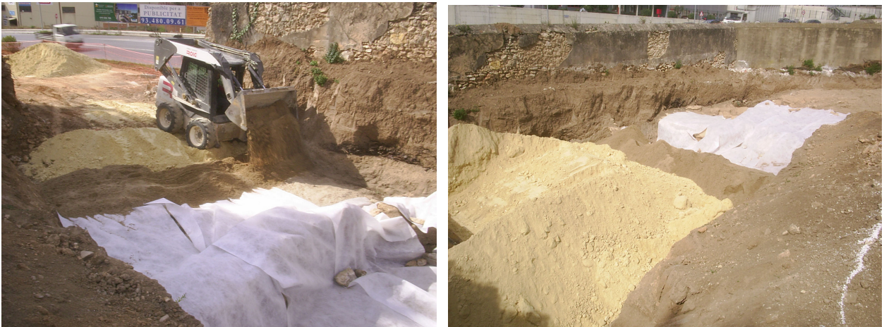
Vista dels treballs de rebliment amb sediment de les estructures
