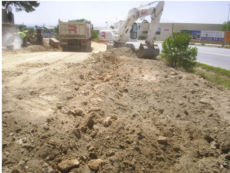
Vista de la neteja mecànica de l'àrea compresa entre la zona excavada i l'actual carretera C-15
