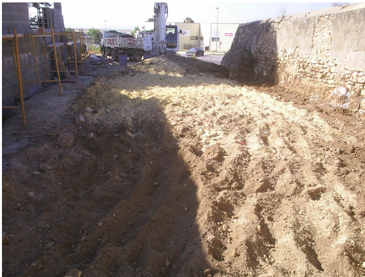
Vista de la rasa de fonamentació del mur
