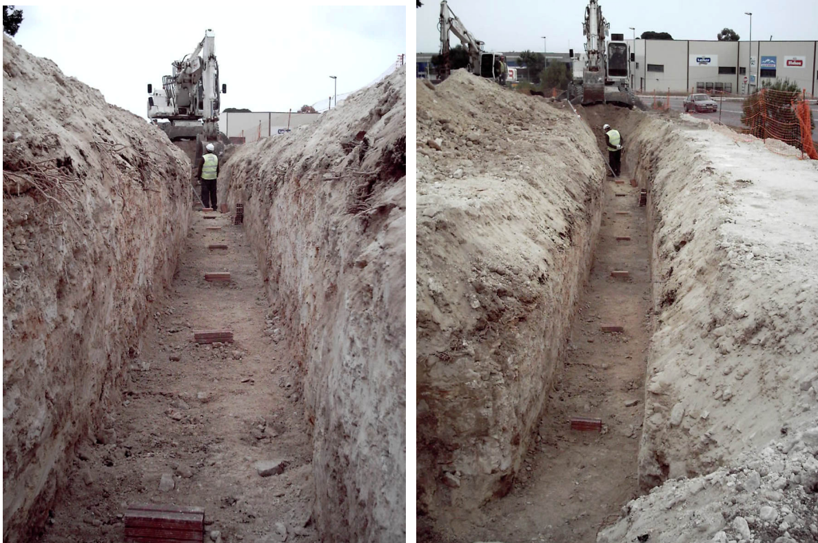
Vista de la rasa per encabir el col·lector
