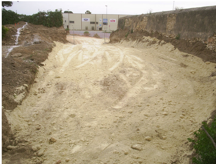
Vista del jaciment un cop finalitzats els treballs de rebliment
