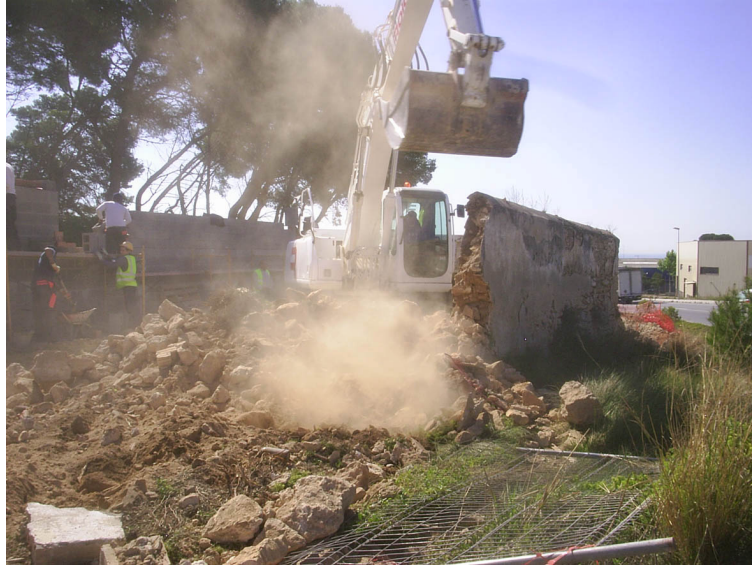
Vista de l'enderroc del mur
