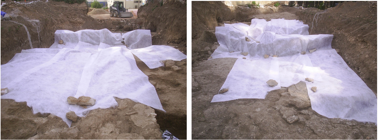
Vista del geotèxtil cobrint les estructures
