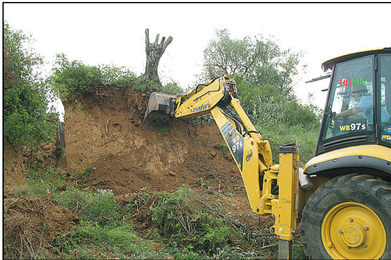
Fig. 2b. - durant la intervenció amb pala mecànica
