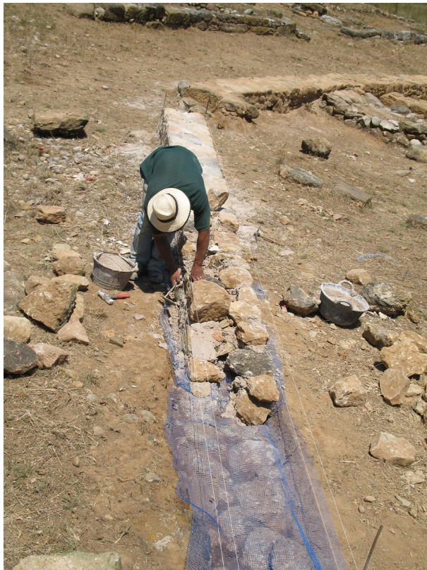
Figura 2. Tasques de consolidació mitjançant l'afegit d'una filada nova de pedres (Mas Castellar 2011)
