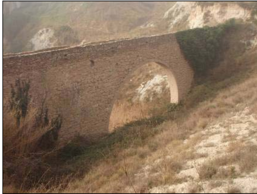
Foto 13: P.A. 147, Aqüeducte de l'Espelt. Pont Gran.
