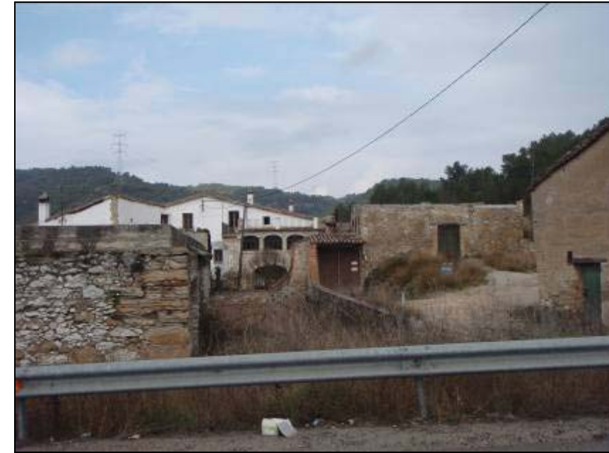
Foto 23: Fachada sur de E.N.C. 15.
