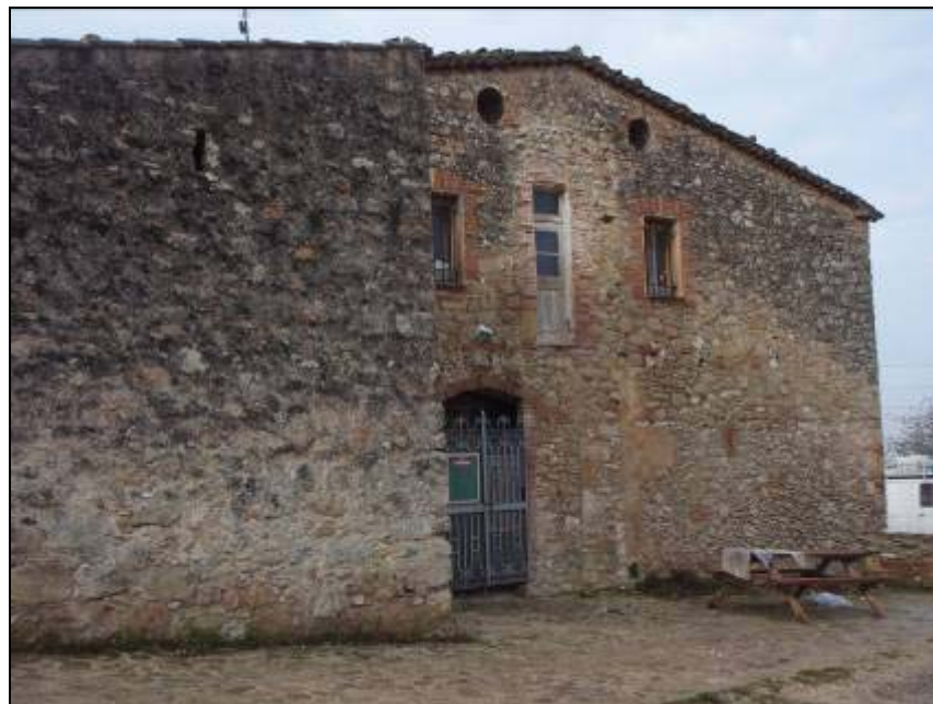
Foto 22: Fachada norte de E.N.C. 15, Cal Lluçà.
