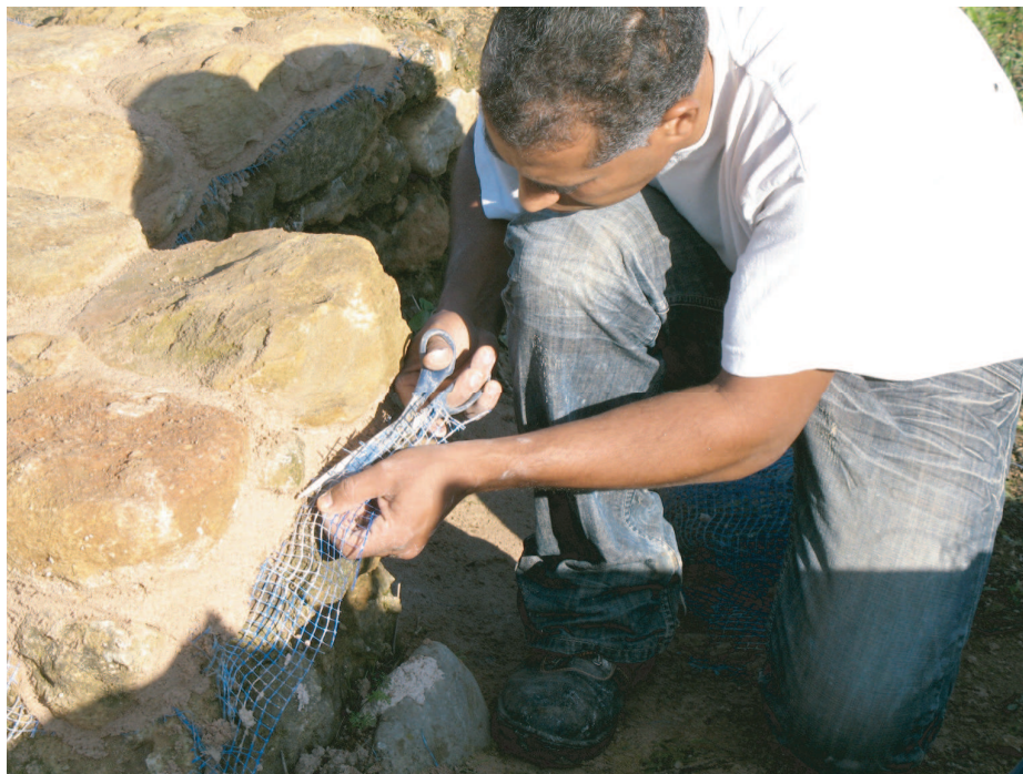
Figura 4. Últims retocs retallant la malla sobrant
