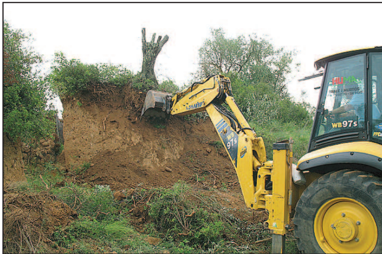
Fig. 2b. - durant la intervenció amb pala mecànica
