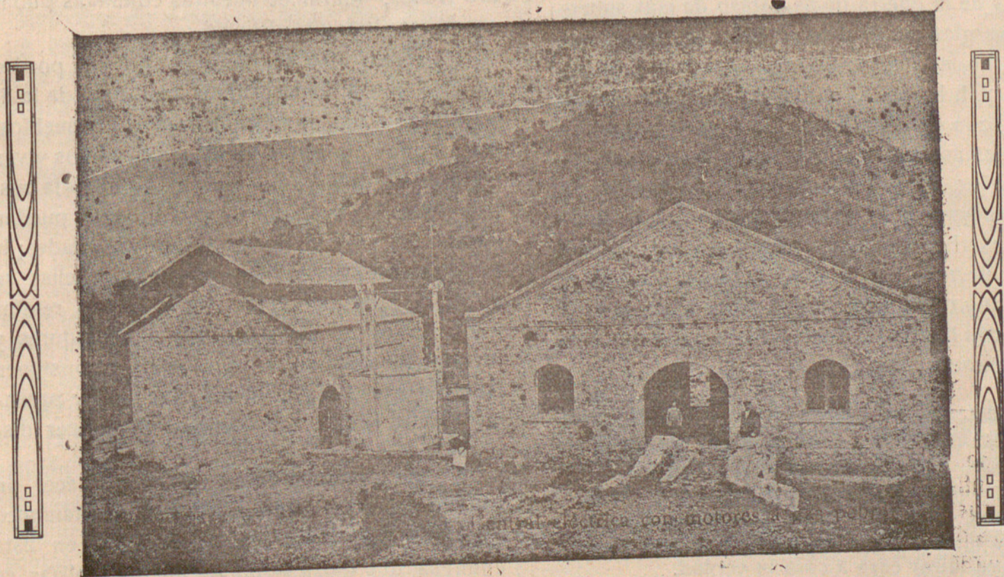
Minas de Berga.—Sub-Central Eléctrica, con motores a gas.
