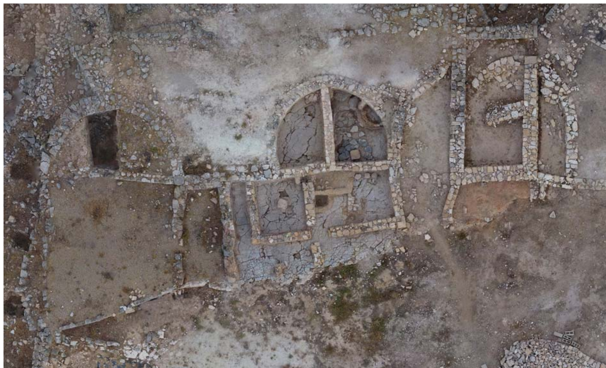
Figura 7. D'esquerra a dreta, vista zenital dels edificis A, B i C (ICAC).
