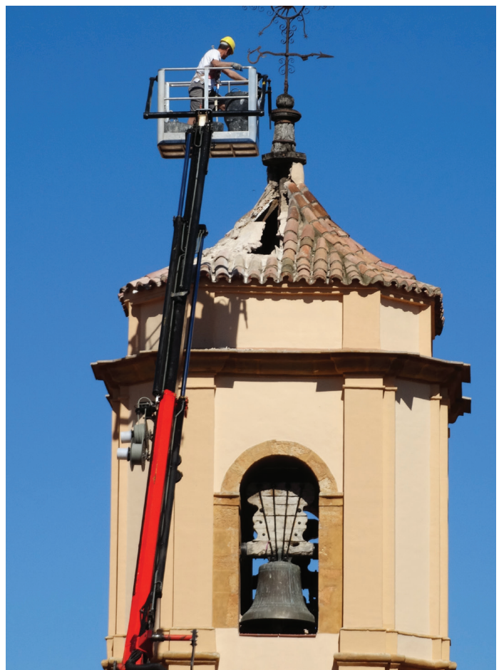
Estéfano Fabregat arregla els danys causats per un llampec al campanar de l'església, el dia 31 de juliol de 2013.
