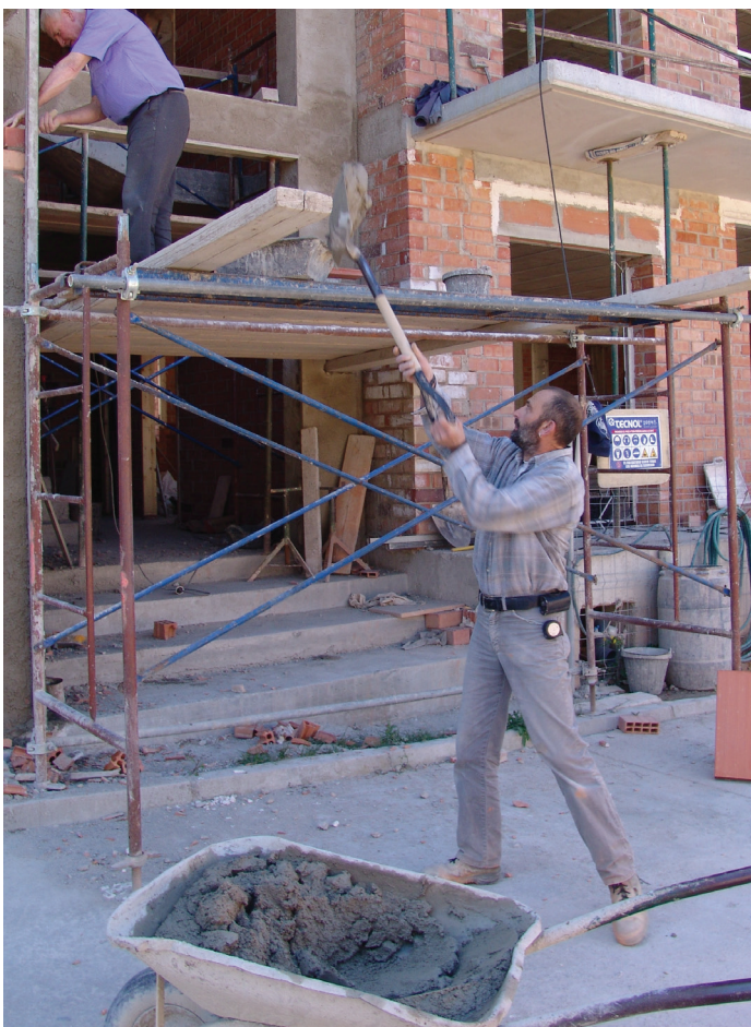
El paleta i el manobre treballant a una façana.
