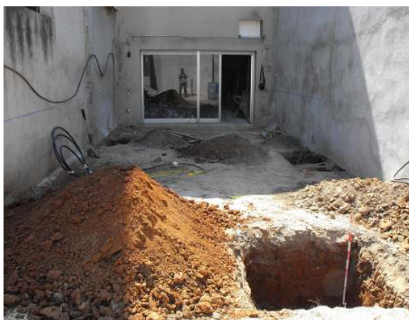
Vista de l'indret a on s'han realitzat les rases perimetrals i la fossa quadrangular a l'espai central.
