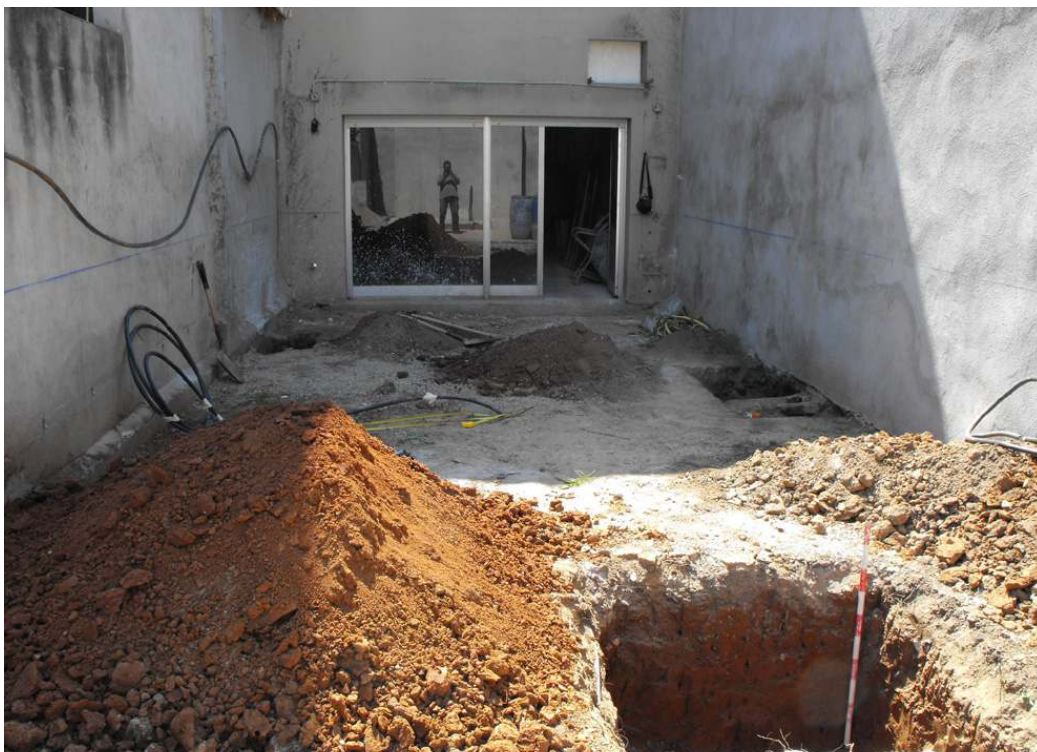
C/CONVENT, 28 (Sabadell, Vallès Occ.). - Vista general del pati de la casa, des de l'est, on s'observa, en primer terme, la fossa oberta per instal·lar un dipòsit. No es van documentar restes arqueològiques.
