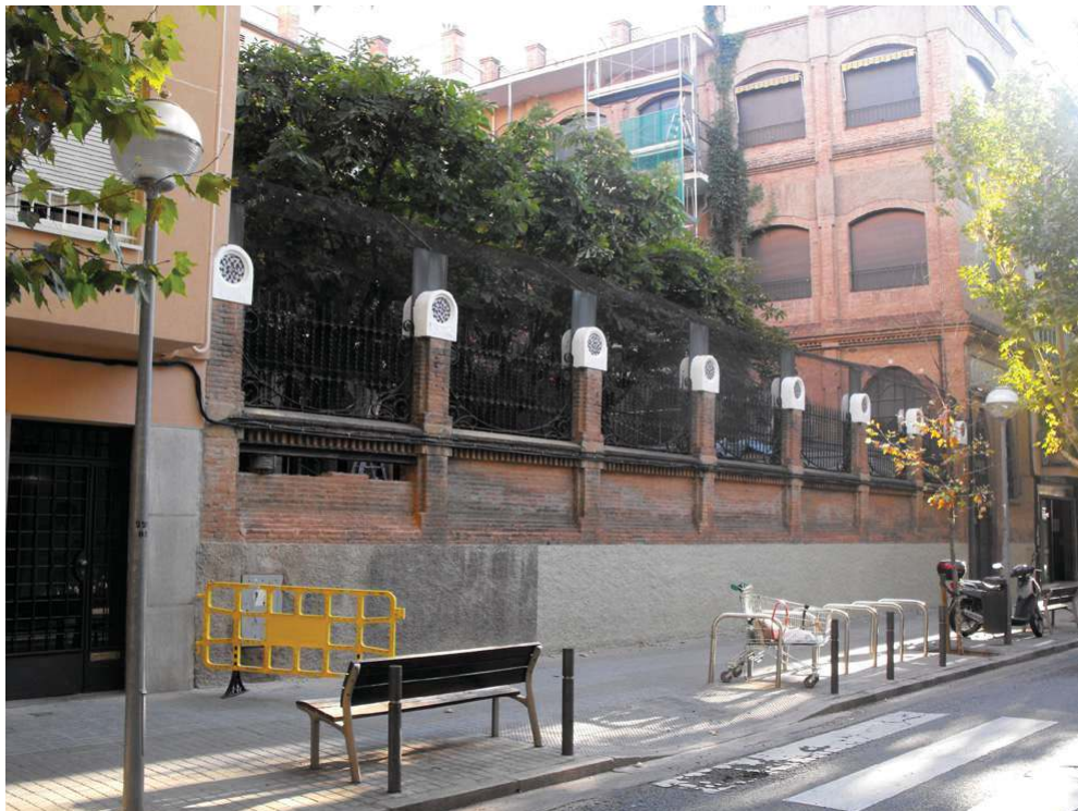
C. DE LA INDÚSTRIA, 9 (Sabadell, Vallès Occ.). - Vista exterior de la façana de la tanca del pati del Col·legi Sagrada Família, des del carrer Indústria.
