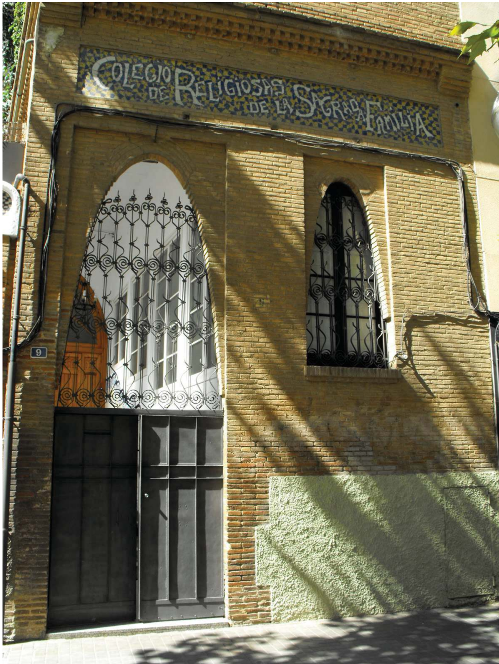
C. DE LA INDÚSTRIA, 9 (Sabadell, Vallès Occ.).- Vista de la façana del Col·legi Sagrada Família, on observem l'accés únic que hi havia fins ara, des del sud.
