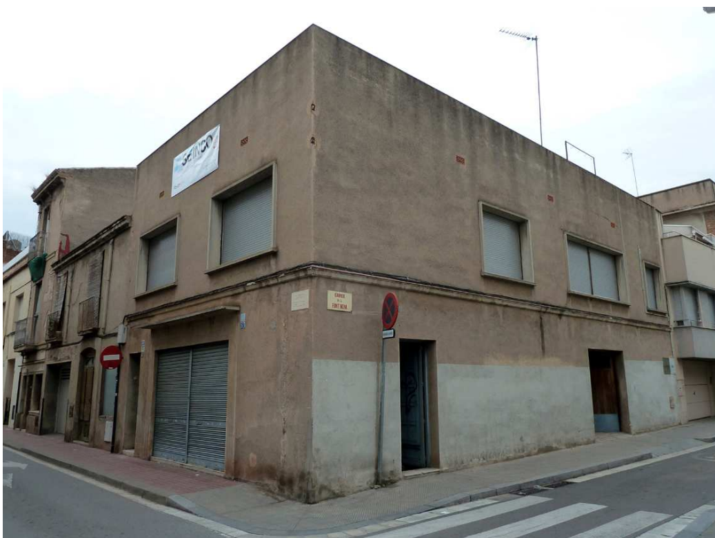
C/ CREUETA, 57 (Sabadell, Vallès Occ.). -Vista de l'edifici a on s'ha dut a terme la intervenció arqueològica, que dóna al carrer de la Creueta i al Carrer de la Font Nova.
