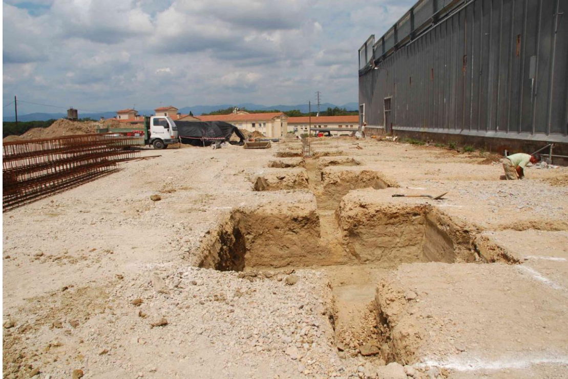
Fig. 12. Imatge dels fonaments, pous i riostres per a la construcció de les botigues
