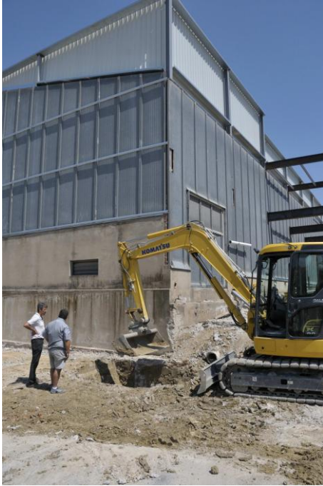
Fig. 5. Realització de diferents pous en el vèrtex sud-oest de l'edifici per comprovar la seva correcta fonamentació. Aparéixen els nivells lutític susceptibles de proporcionar material paleontològic.
