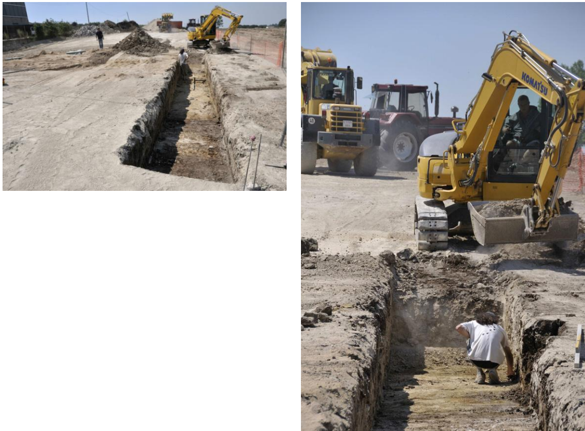
Fig. 1. Treballs de seguiment de la gran rasa de fonamentació en el límit oest del sector comercial.
