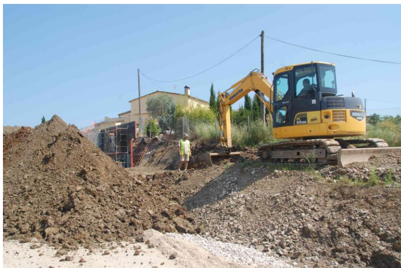
Fig. 14. Seguiment de màquina a la zona del rebaix del pàrking que faltava per fer.
