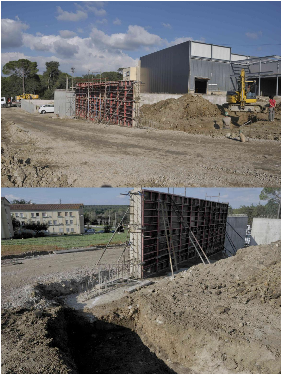
Fig. 27. Imatges de la rasa de fonamentació que ha de servir de continuïtat del mur de contenció en el vèrtex sud-oest de la zona de la benzineria.
