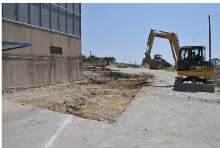
Fig. 4 aixecament de la capa de formigó abans d'accedir als nivells in situ inferiors.
