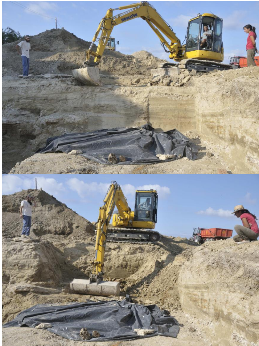
Fig. 27. Treballs d'ampliació en el vèrtex sud-est de la cala "benzinera"
