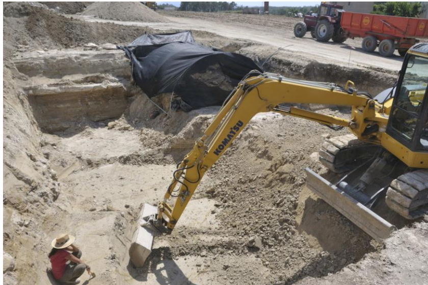
Fig. 28. Treballs de seguiment de la cala benzinera on hi ha d'anar instal·lats els dipòsits.
