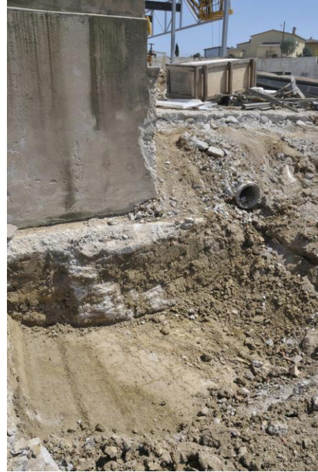
Fig. 5. Realització de diferents pous en el vèrtex sud-oest de l'edifici per comprovar la seva correcta fonamentació. Aparéixen els nivells lutític susceptibles de proporcionar material paleontològic.
