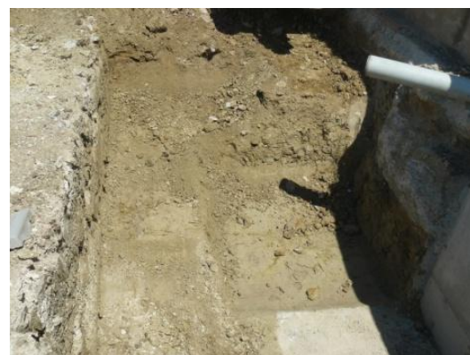
Fig 5. Imatge dels treballs d'excavació de la rasa.
