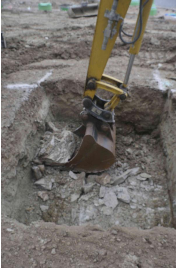
Fig. 29. Seqüència del seguiment de la construcció del pou on instal·lar el dipòsit d'aigua.
