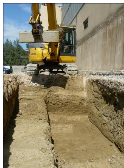
Fig 8. Imatge dels treballs d'excavació del segon tram de rasa.
