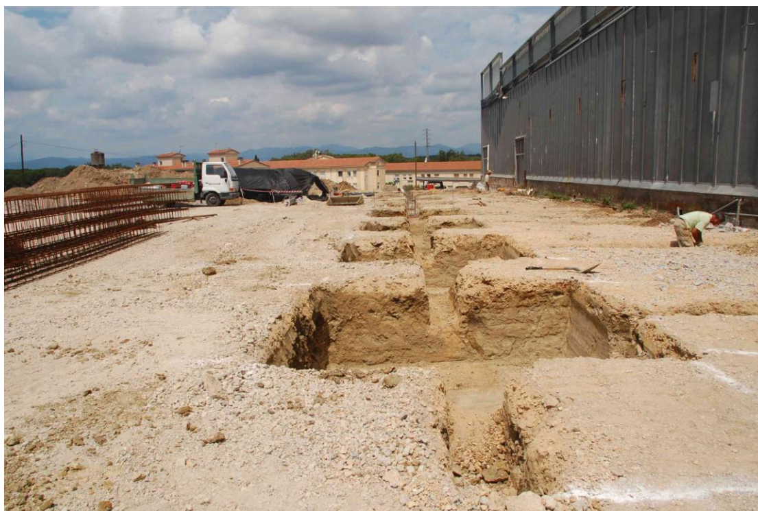
Fig. 21. Imatge dels fonaments, pous i riestres per a la construcció de les botigues
