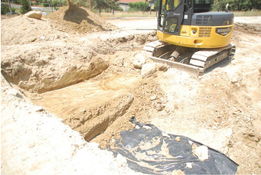
Fig. 26. Ampliació de forat pels dipòsits de benziner a la zona on ha aparegut les restes de tapir (tapades amb una lona negra).
