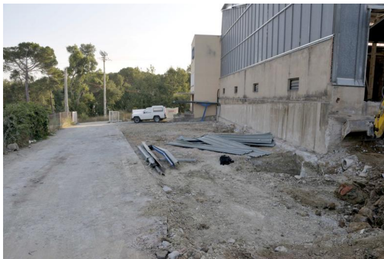
Fig. 6. Vista dels treballs d'aixecament de les planxes de formigó superficial a la part de l'entrada del centre comercial
