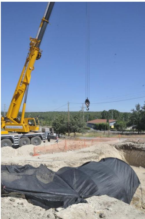
Fig. 37. Treballs de col·locació dels grans dipòsits de la gasolinera.
