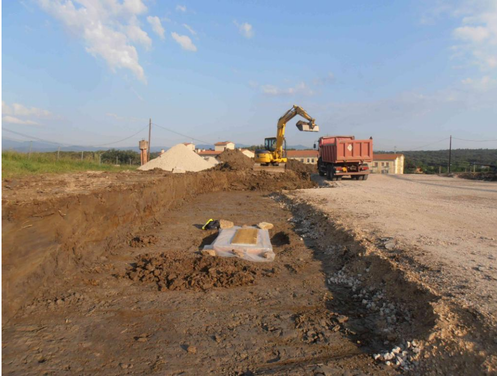
Fig. 13. Situació de l'esquelet humà (zona coberta per plàstic i tauler d'encofrar). La tanca de l'esquerra indica el límit sud de la parcel·la.
