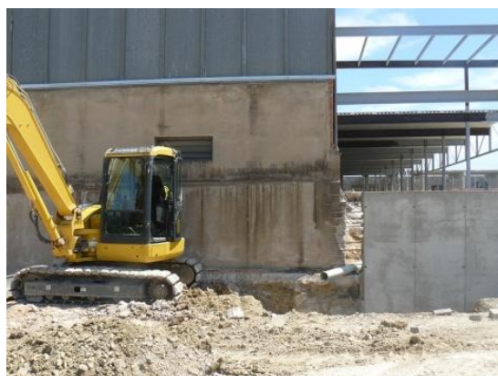
Fig 4. Inici dels treballs de la Rasa amb màquina retroexcavadora
