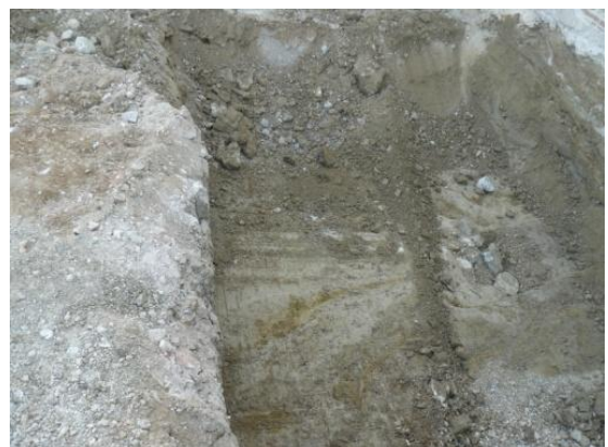
Fig 12. Imatges del treball d'excavació de la rasa fonamentació transversal
