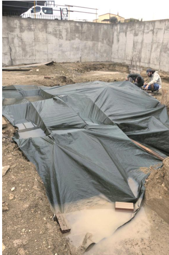
Fig. 20. Detall de la lona de plàstic que ha protegit l'àrea d'excavació i que s'ha vist parcialment inundada.
