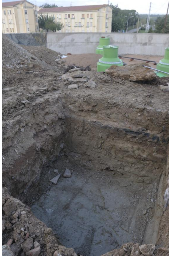
Fig. 22. Obertura dels diferents pous de serveis de la benzinera.
