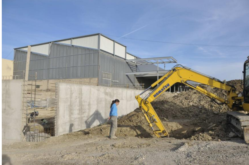
Fig. 12. Seguiment de màquina de la rasa de fonamentació de la part sud-est d'aquesta zona.
