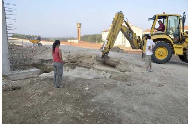
Fig. 11. Treballs d'ampliació de l'àrea d'actuació mitjançant una màquina retroexcavadora
