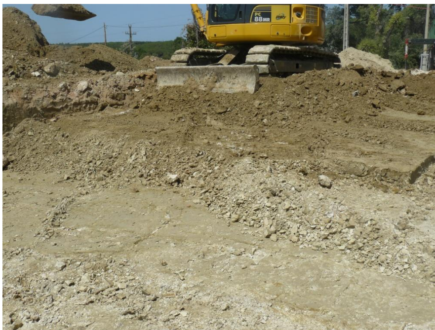
Fig 13. Imatge general dels treballs d'excavació del rebaix general.
