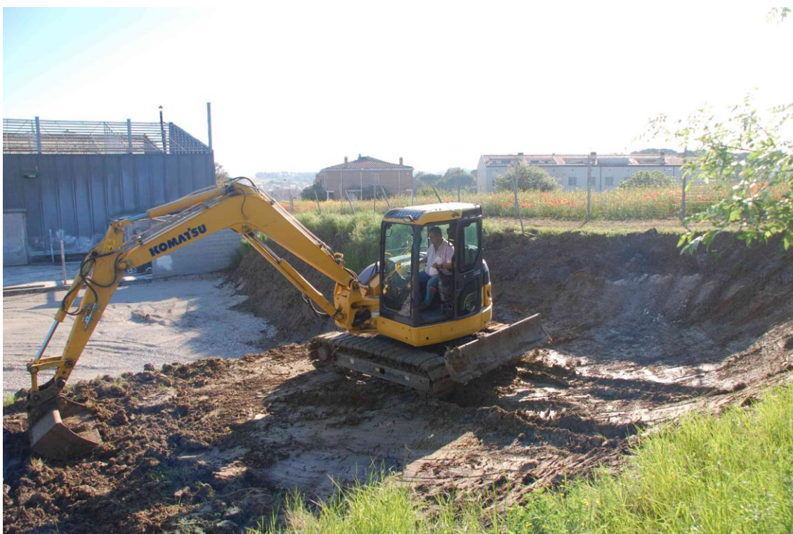
Fig. 11. Seguiment dels moviments de terra en el moment de fer els rebaixos per a la construcció del pàrking
