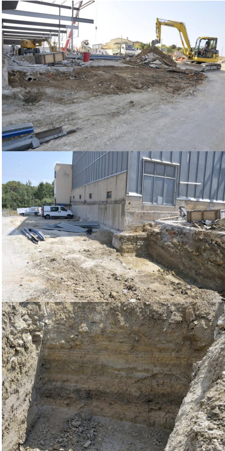
Fig. 7. Vista del tall realitzat per la rasa de fonamentació on es veuen clarament les diferents successions de capes lutítiques barbades.
