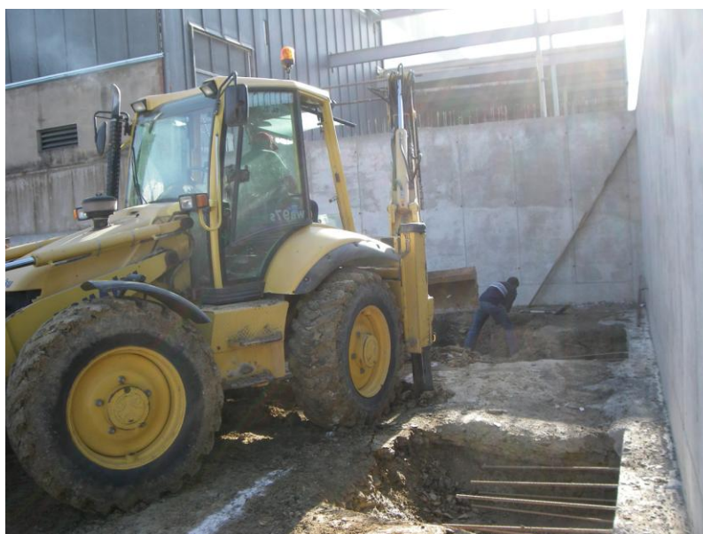
Fig. 1. treballs de realització de pous en el vèrtex sud-est del sector benzinera.
